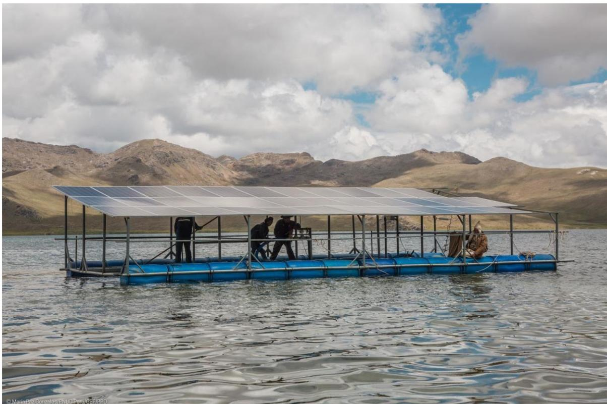
*Piattaforma galleggiante con pannelli solari per il pompaggio dell'acqua del lago per l'irrigazione dei pascoli circostanti (UNPD Perù)*
