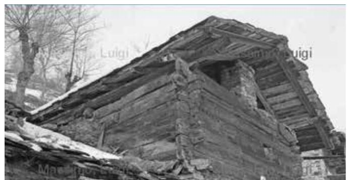
FIG.2.14 - Massimo L., *Struttura a Blockbau (Serre, Celle Macra)*, Escarton, aggiornato al 1981
