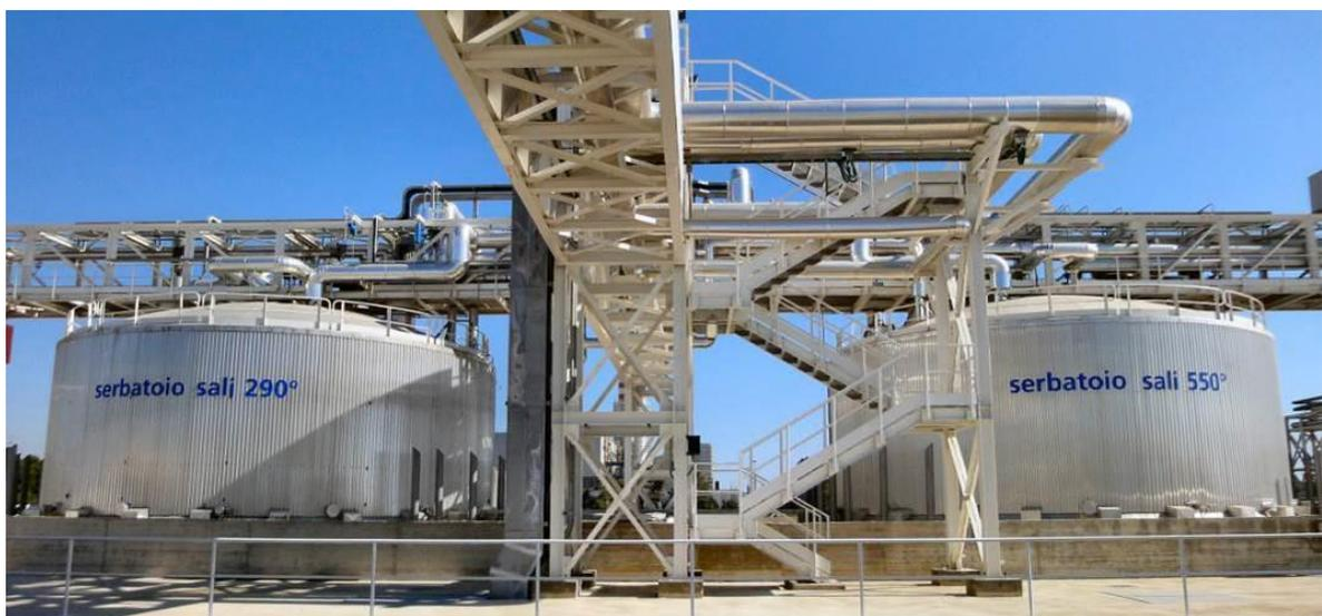
Figura 28- Fotografia dei due serbatoi utilizzati per l'accumulo di un impianto CSP [30]
