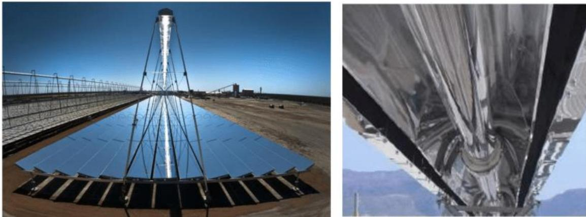
Figura 13- Esempio di impianto LFR (a sinistra), dettaglio dell'assorbitore (a destra) [32]
