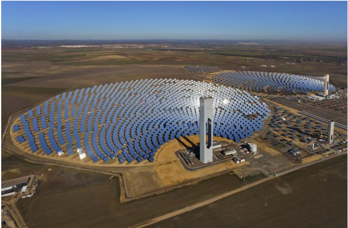
Figura 22- Esempio di impianto a torre centrale [36]
