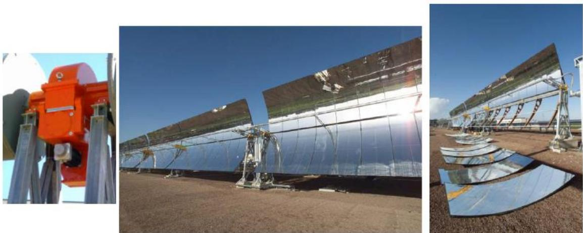
Figura 11- Da sinistra: sistema di movimentazione, collettori parabolici lineari a fine installazione, specchi e struttura durante la fase di montaggio [30]
