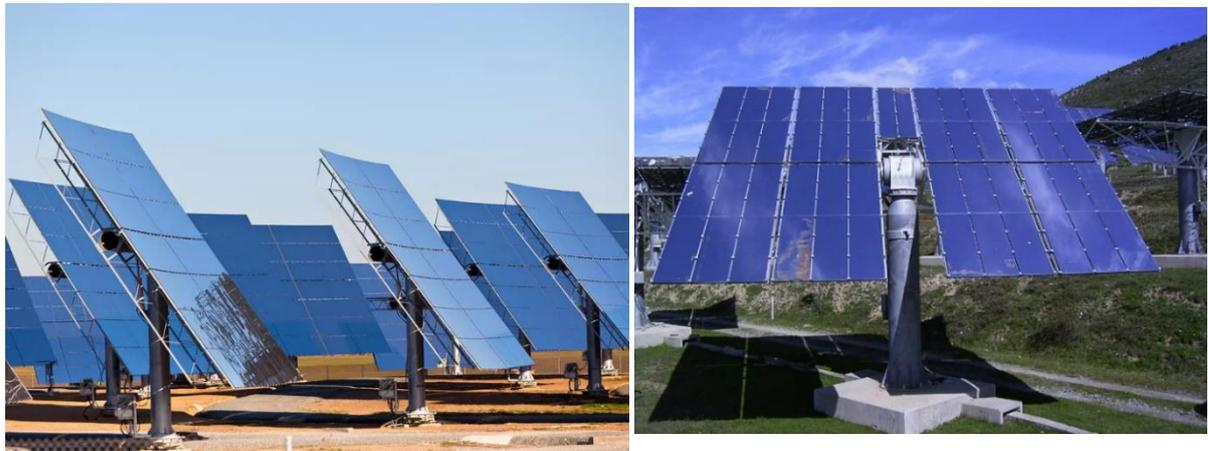
Figure 20 e 21- Esempi di eliostati impiegati negli impianti CRS [36][37]
