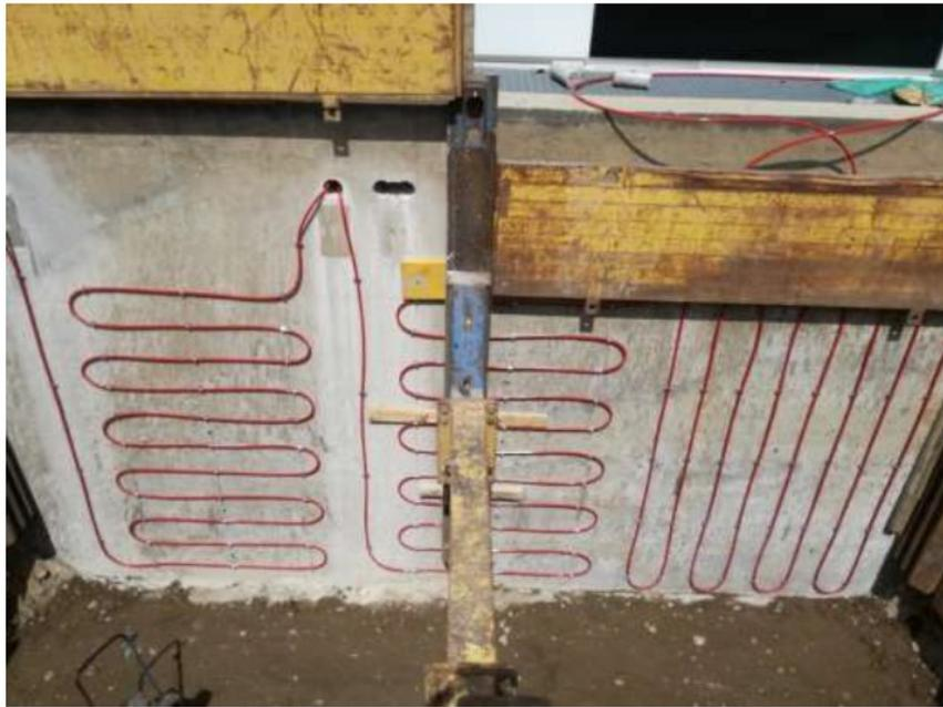
*Figura 49: muro energetico dell'Energy center lab di Torino prima di essere ricoperto con il terreno*
