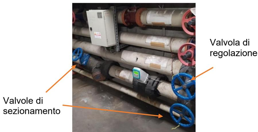
*Figura 82 - Esempio di valvole di sezionamento e regolazione*
