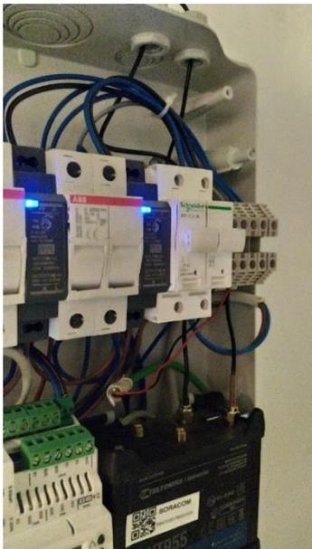
Figura 98 - Alimentatori delle valvole
