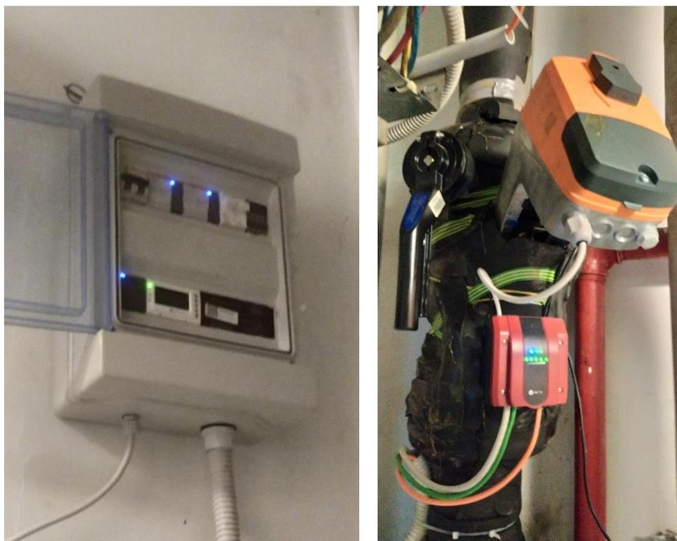
Figura 90 - A sinistra: quadro di regolazione; a destra: valvola di regolazione indipendente dalla pressione
