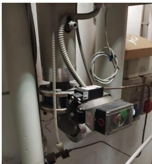
Figura 86 - Valvola di sezionamento a monte di C01 non funzionante
