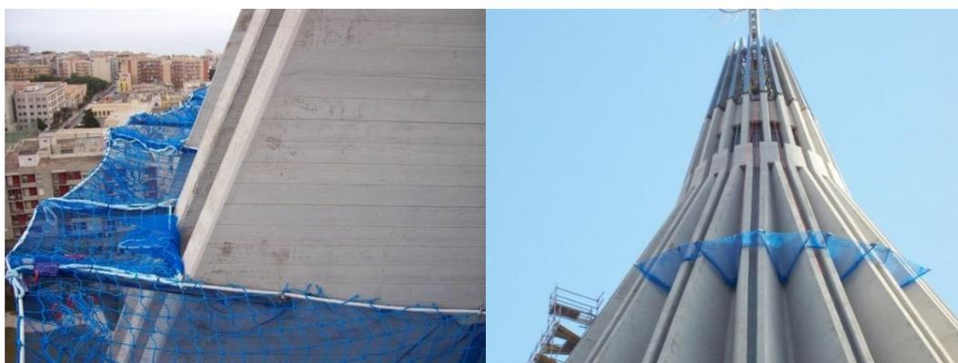
**Figure 1.6-1.7.** Esempio sistema T – Retificio Far Reti.
