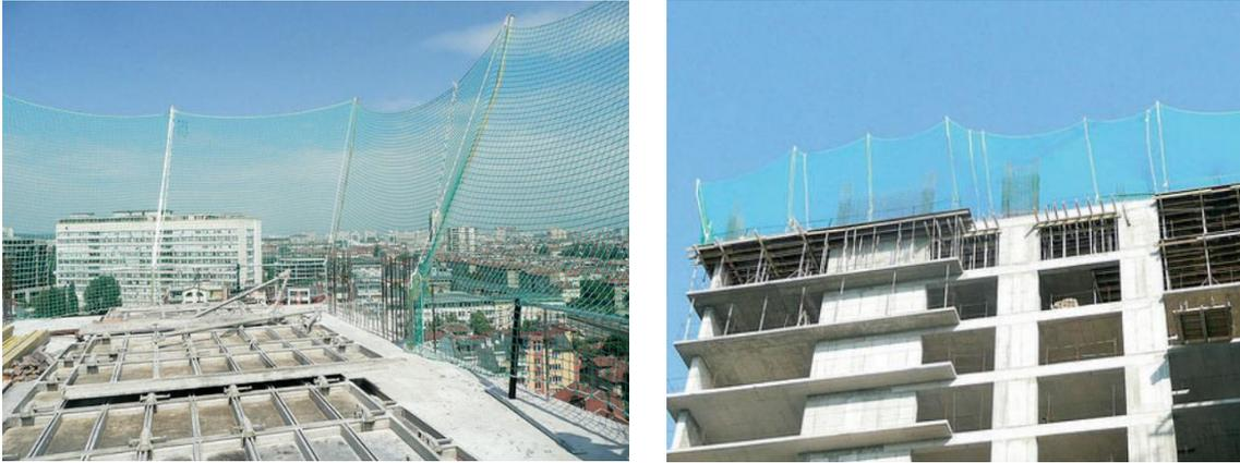
**Figure 1.12-1.13.** Esempio sistema V – INAIL, Quaderni di ricerca n.15.
