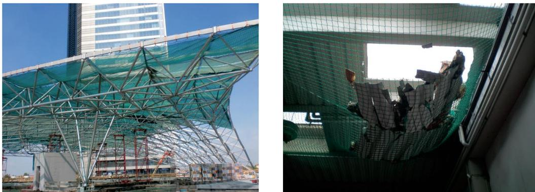
**Figure 1.3-1.4.** *A sinistra: esempio sistema S, copertura in acciaio. A destra: esempio sistema S, protezione caduta materiale – INAIL, Quaderni di ricerca n.15.*
