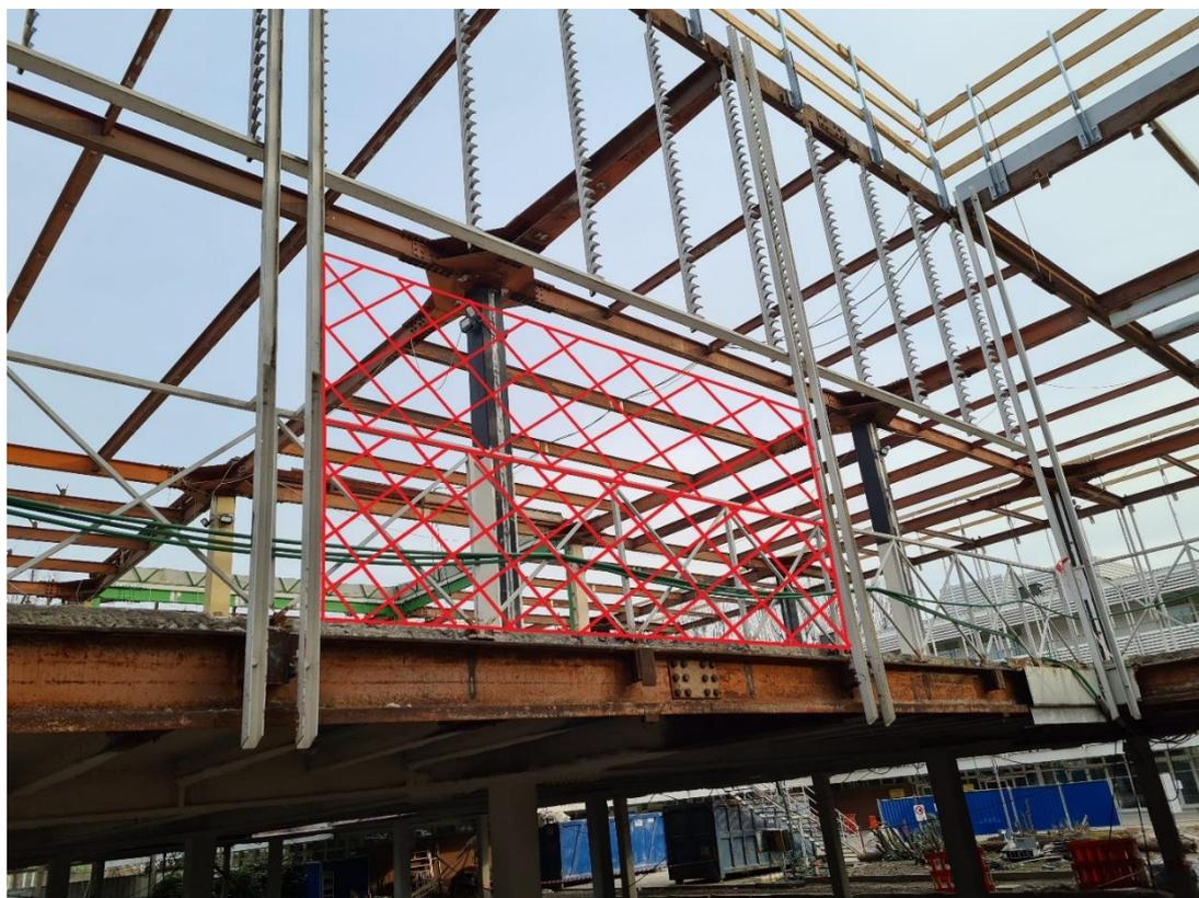
**Figura 3.12.** *Applicazione della rete di sicurezza.*
