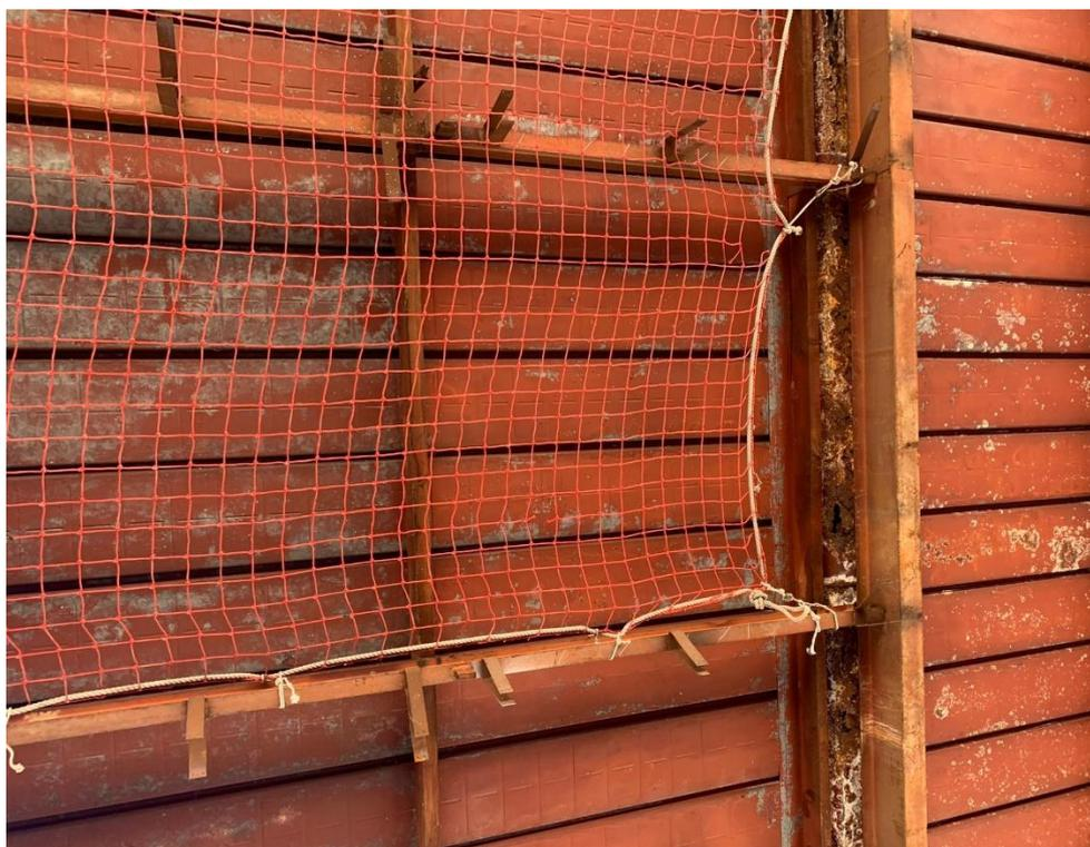
**Figura 3.7.** Reti di sicurezza anticaduta, dettaglio ancoraggio.
