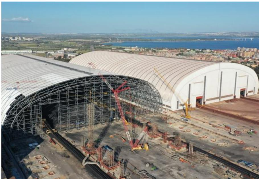
*Figura 29 Copertura dell'acciaieria ILVA a Taranto, luce complessiva 254 metri.*
