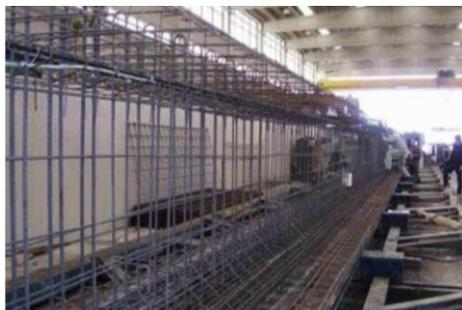
*Figura 7 - Sensori in fibra ottica collegata alle barre di armature all'interno di una trave*
