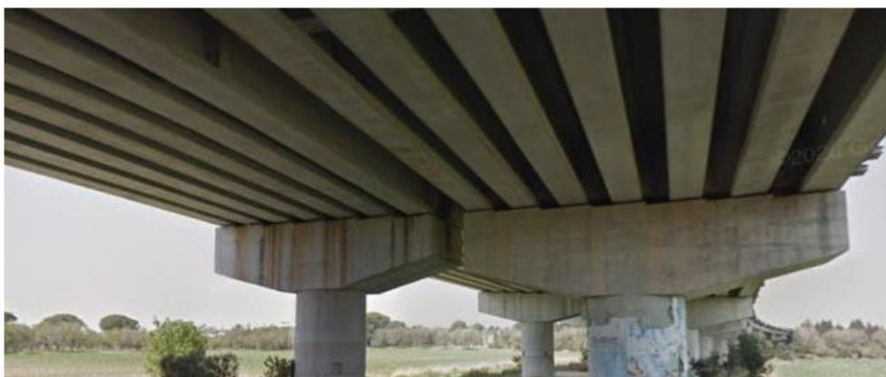
*Figura 15 - Viadotto con impalcati a graticcio*
