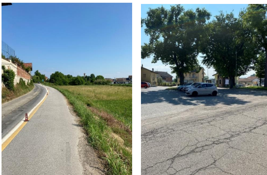
Figura 92 Foto del sopralluogo - caso studio
