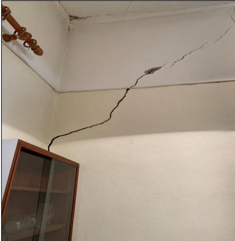
*Figura 37: lesione croce di muro Nord/Ovest (piano terra)*
