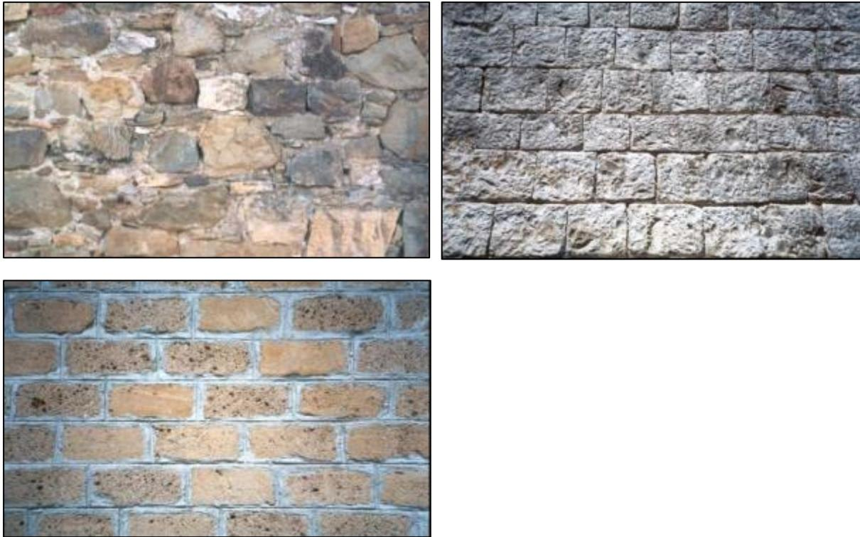
*Figura 4: da sinistra verso destra, paramento di muratura a sacco con elementi in pietra non squadrati con apparecchiatura disorganizzata ed irregolare, paramento singolo di elementi in pietra ben squadrati e di accurata fattura, paramento con blocchi di tufo con dimensioni standard*
