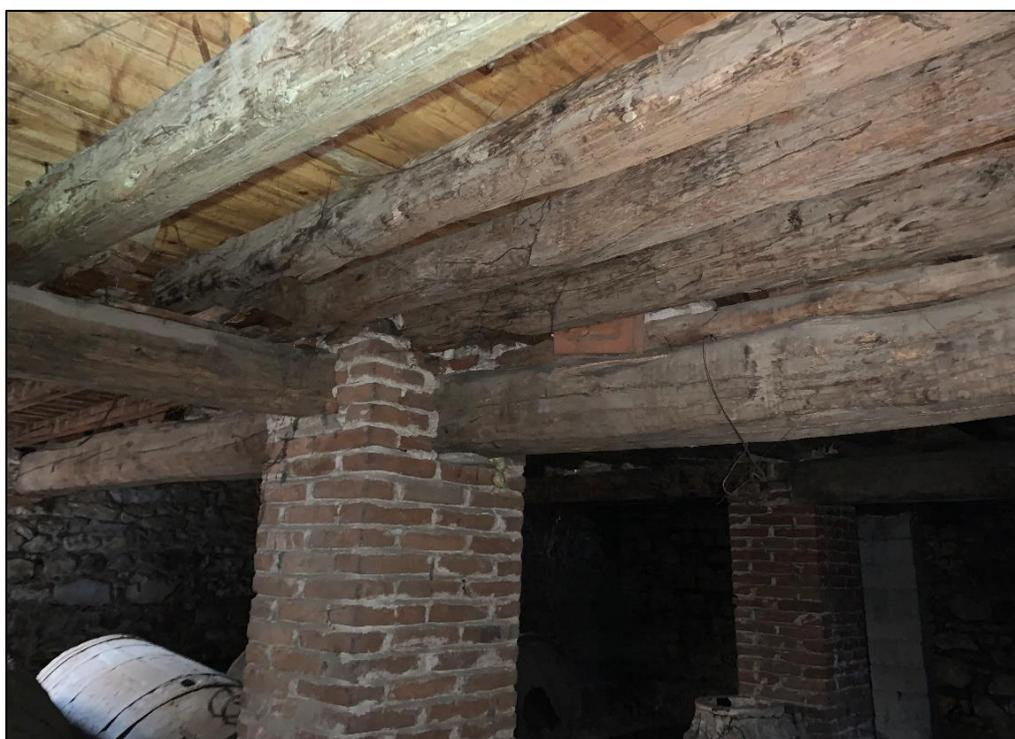
*Figura 19: particolare pilastro e seminterrato*
