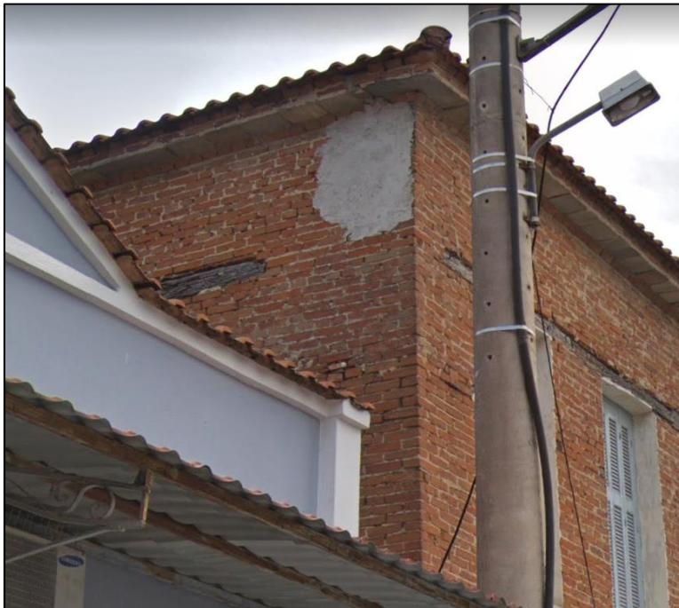
*Figura 34: probabile lesione croce di muro Nord/Ovest*
