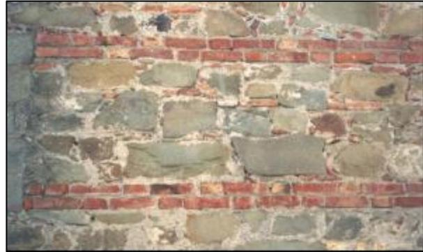
Figura 9: da sinistra a destra possibile configurazione nello spessore e paramento con matrice principale in pietra discretamente squadrato con listature in mattoni pieni
