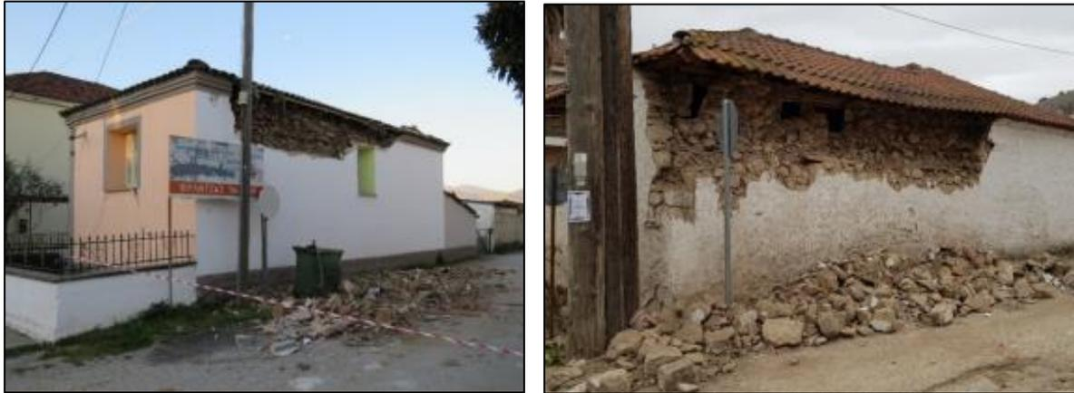
*Figura 39: danni rilevati su struttura in muratura*
