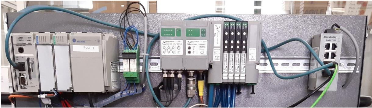
*Figura 106: guida DIN con PLC, relè controllo motore, batteria di valvole e switch di rete*
