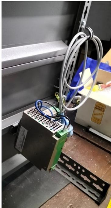
*Figura 102: installazione dell'alimentatore sul lato posteriore del pannello*
