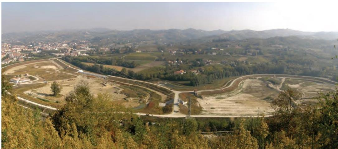
*Figura 7: Cassa di espansione in derivazione del Torrente Belbo*
