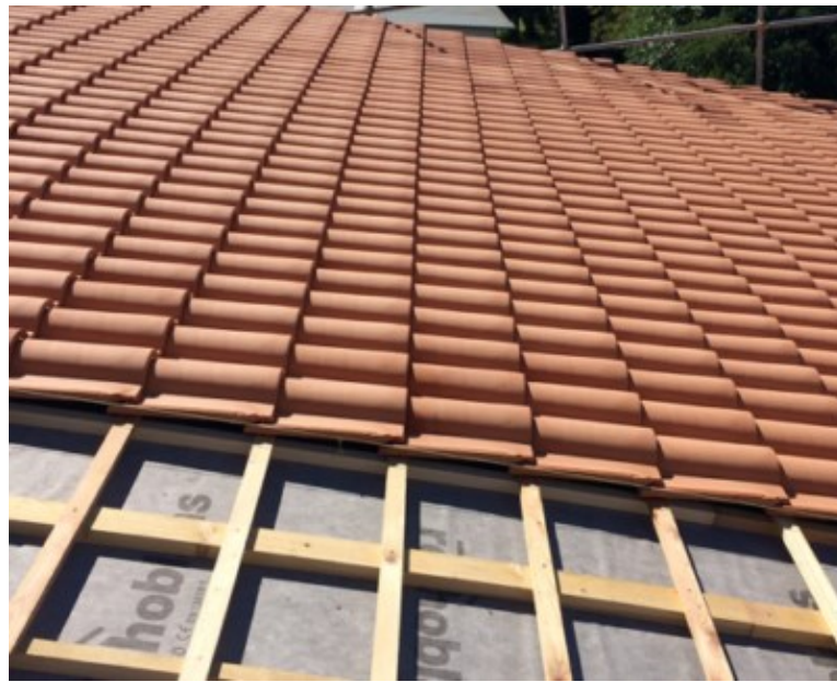
Figura 4-10-Listellatura per posa nuovo manto- Fonte: https://soluzioni-edili.it/tetto-isolato-e-ventilato/
