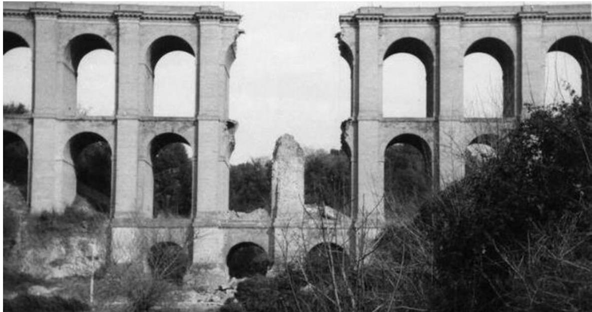
Figura 24 – Crollo del ponte di Ariccia nel 1967. Fonte: <https://www.castellinotizie.it/>
