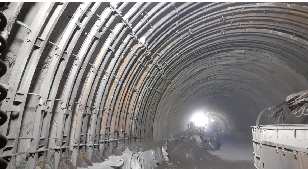
Figura 15 – Centine metalliche usate per la realizzazione di interventi conservativi in galleria.
