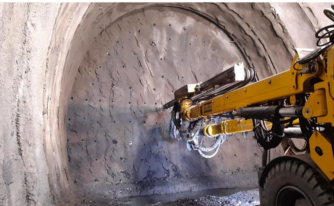
Figura 17 – Perforazione del fronte per la volata. Fonte: <https://www.terzovalico.it/>
