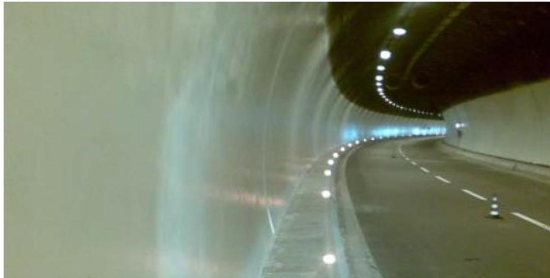
Figura 39 – Esempio di installazione LED a marciapiede condotta nella galleria Perosa della A32. Fonte: Elaborati prodotti da Musinet Engineering SpA
