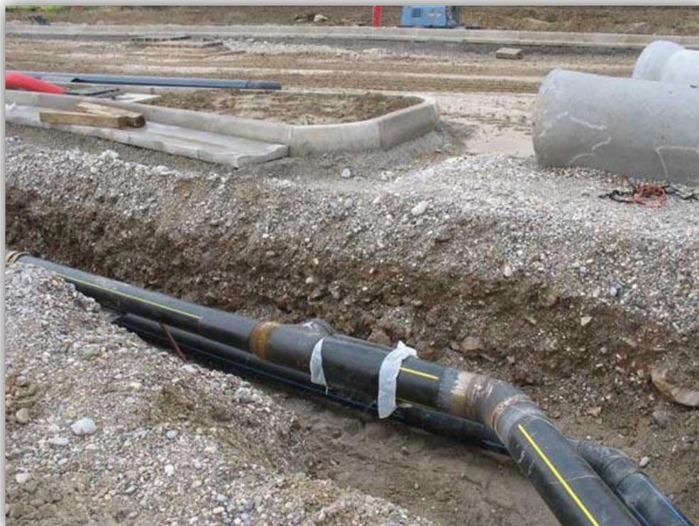
Figura 10 Foto tubazione in PE (<https://www.duecsnc.com/costo-realizzazione-nuovo-allacciamento-gas-casa-posa-tubazioni-interrate-lodi-fiorenzuola-arda/>)
