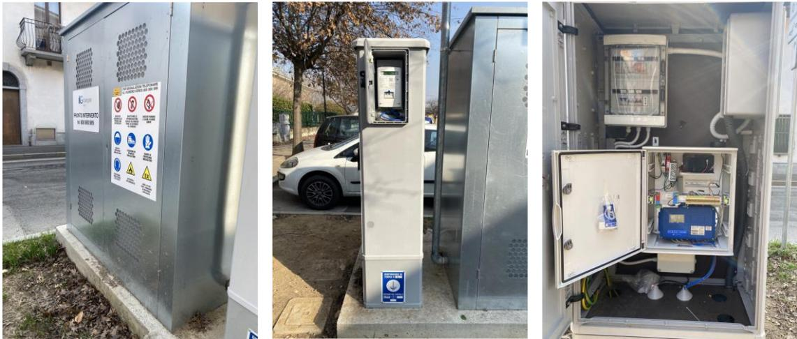
*Figura 26 - A) armadio GRFD; B) Armadio VTR con contatore (rif. GRFD); C) RTU e interruttori.*
