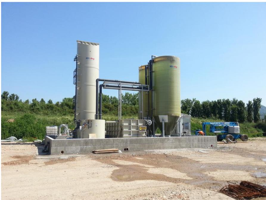
Figura 42 – Immagine raffigurante una torre di lavaggio e il relativo sistema di sedimentazione (Fonte: Airdep);
