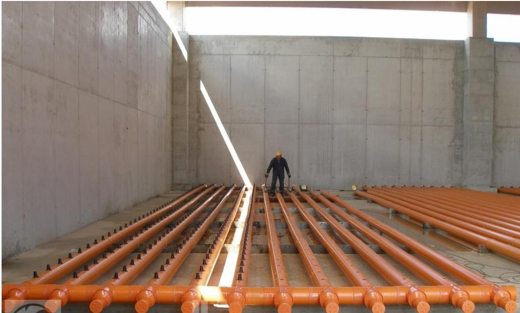
*Figura 34 – Sistema di aerazione e raccolta percolati a pavimento (Fonte: MVTplant);*
