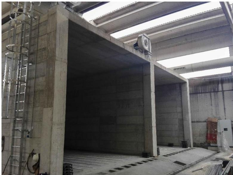
Figura 33 – Immagine raffigurante delle biocelle in fase di realizzazione (Fonte: Smeda);
