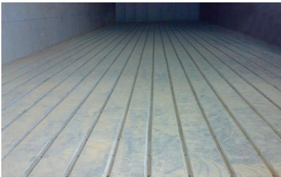
*Figura 35 – Pavimentazione delle biocelle a fine realizzazione (Fonte: MVTplant);*
