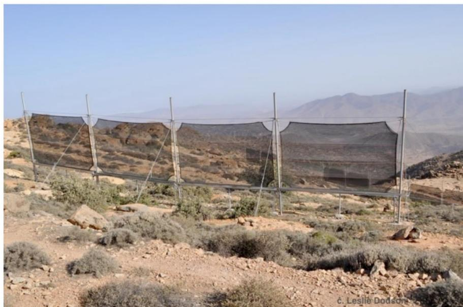
*Figura 74 - Sistema di raccolta dell'acqua di nebbia di Dar Si Hmad (Dodson e Bargach, 2015)*
