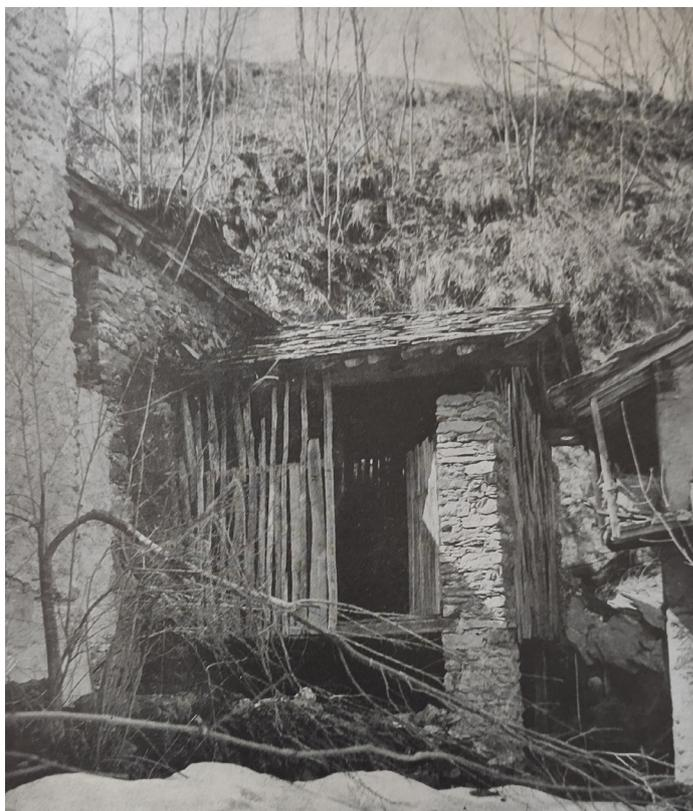
Fig.8\_Fienile a Forno di Lemie, da notare il sistema di tamponamento con assi di legno leggermente scostate tra loro e con dimensioni diverse
