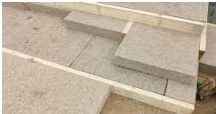
Fig. 4\_Messa in opera di pannelli isolanti in canapa
