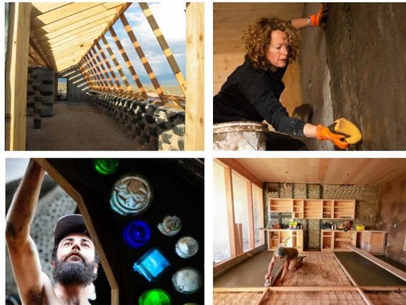
Figura 28. Fotografie in cui si vede la costruzione della serra (in alto a sinistra), opere di finitura interna (in alto a destra), decorazioni con bottiglie di vetro (in basso a sinistra) e la fase di pavimentazione (in basso a destra).
