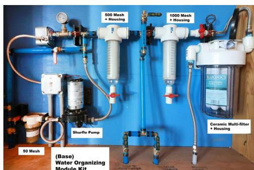
Figura 22. Fotografia in cui è visibile il sistema WOM di smistamento dell'acqua bianca.
