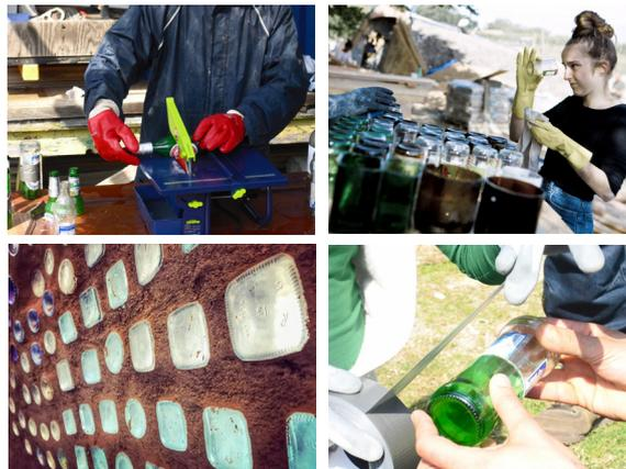
Figura 27. Fotografie in cui si vede l'attrezzo attraverso cui vengono tagliate le bottiglie di vetro (in alto a sinistra), la pulizia delle bottiglie di vetro tagliate (in alto a destra), un muro fatto con le bottiglie di vetro (in basso a sinistra) e un mattone di vetro (in basso a destra).
