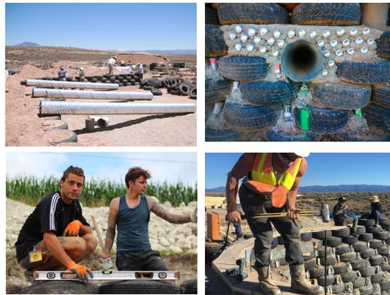
Figura 25. Fotografie in cui compaiono i tubi di refrigerazione non ancora integrati (in alto a sinistra) e integrati (in alto a destra), il livellamento del muro di pneumatici (in basso a sinistra) e il muro portante ultimato prima di esser ricoperto (in basso a destra).
