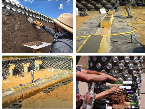
Figura 26. Fotografie in cui compare il muro portante intonacato (in alto a sinistra), la predisposizione del basamento per la parete portante in legno (in alto a destra), la costruzione dei contrafforti e la predisposizione della serra (in basso a sinistra) e un contrafforte con bottiglie di vetro e cemento (in basso a destra).
