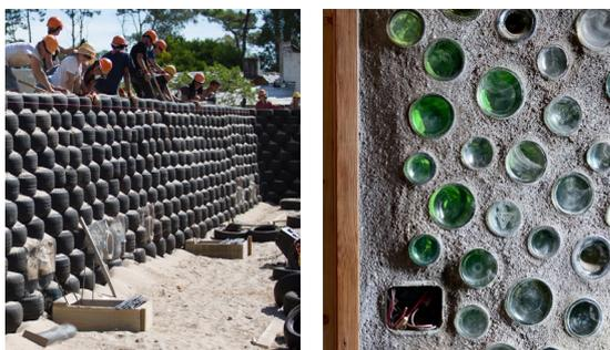
Figura 17. Fotografie in cui è visibile il muro portante (a sinistra) fatto di pneumatici pieni di terra battuta e una partizione interna (a destra) costituita da impasto di terra, eco-cemento e bottiglie di vetro.
