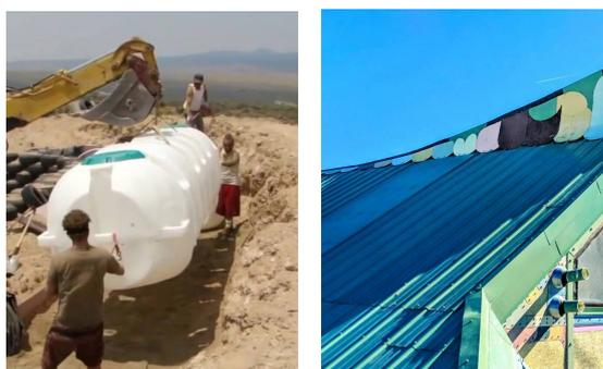
Figura 20. Fotografie in cui è visibile la cisterna di accumulo dell'acqua (a sinistra) e le lamiere della copertura inclinata (a destra).
