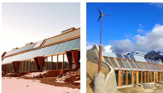
Figura 19. Fotografie in cui è visibile l'impianto di pannelli fotovoltaici (a sinistra) e una turbina eolica (a destra).
