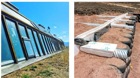
Figura 18. Fotografie in cui è visibile la serra utile a ottimizzare il guadagno solare (a sinistra) e i tubi di aerazione per il raffrescamento (a destra).
