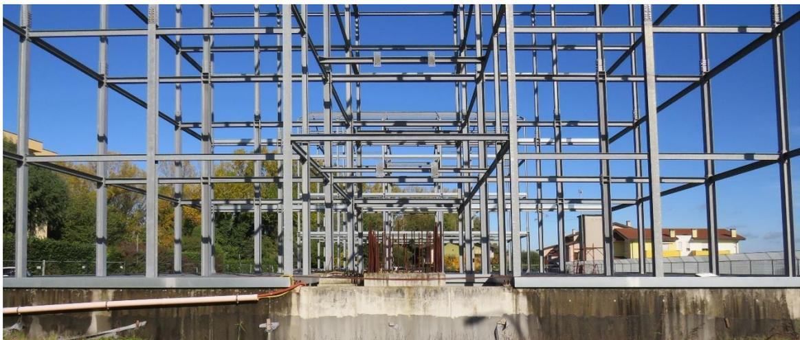
Figura 15: Focus sul basamento in cls
