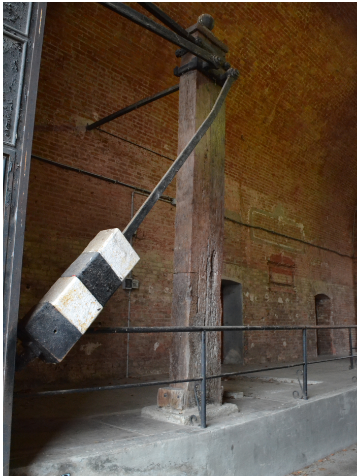
Fig.4-Meccanismi del ponte levatoio. Foto del 25/01/2022
