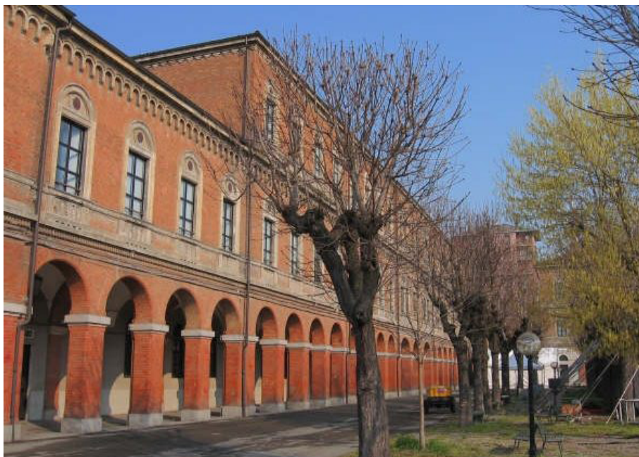
Fig.12- Vista padiglione comando interno. Foto del 27/01/2022
