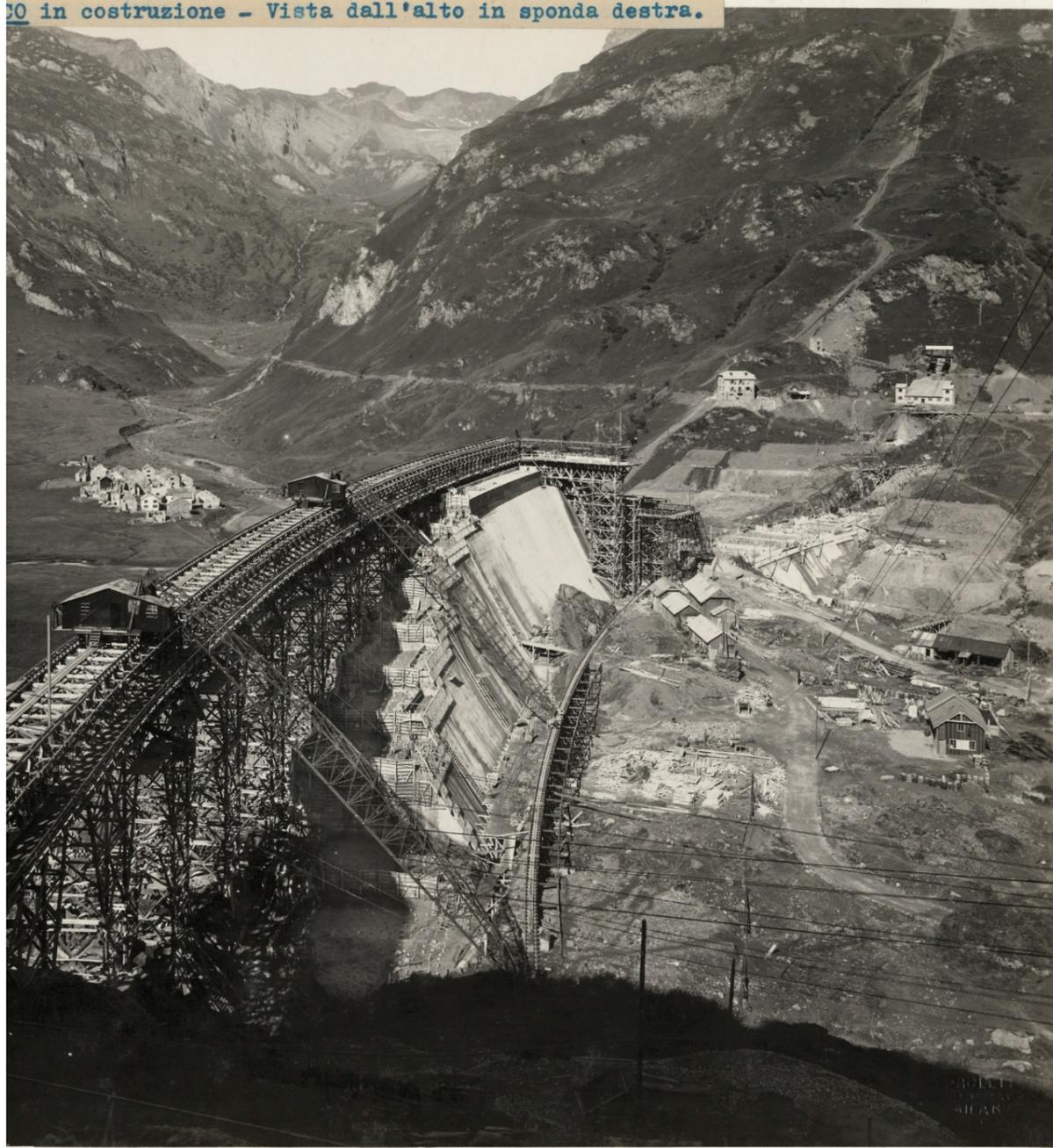
Figura 37. Diga di Morasco in costruzione, vista dall'alto in sponda destra, 1938
