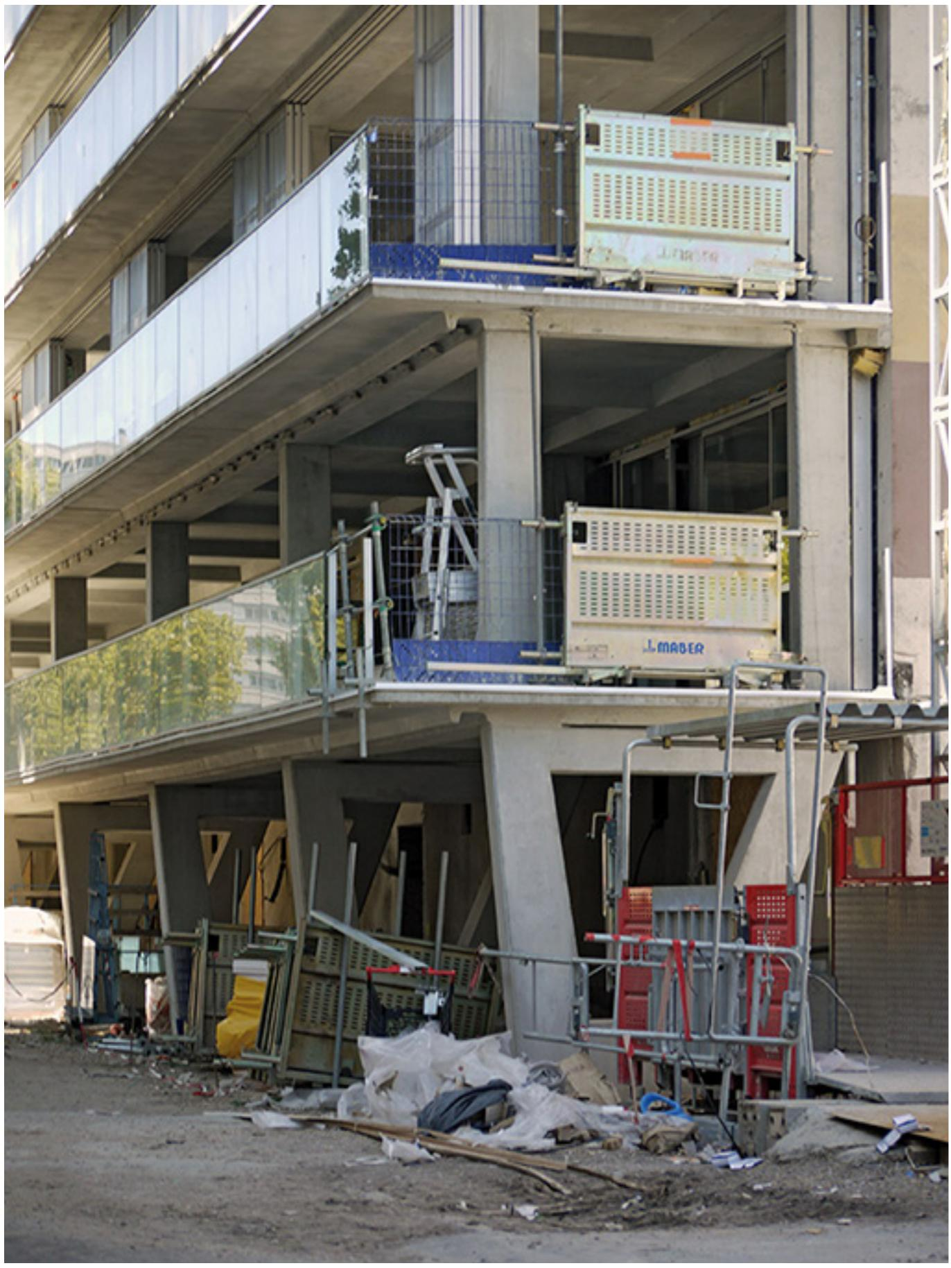
Utilizzo di un sistema prefabbricato per l'estensione di un edificio esistente mediante una serra bioclimatica
