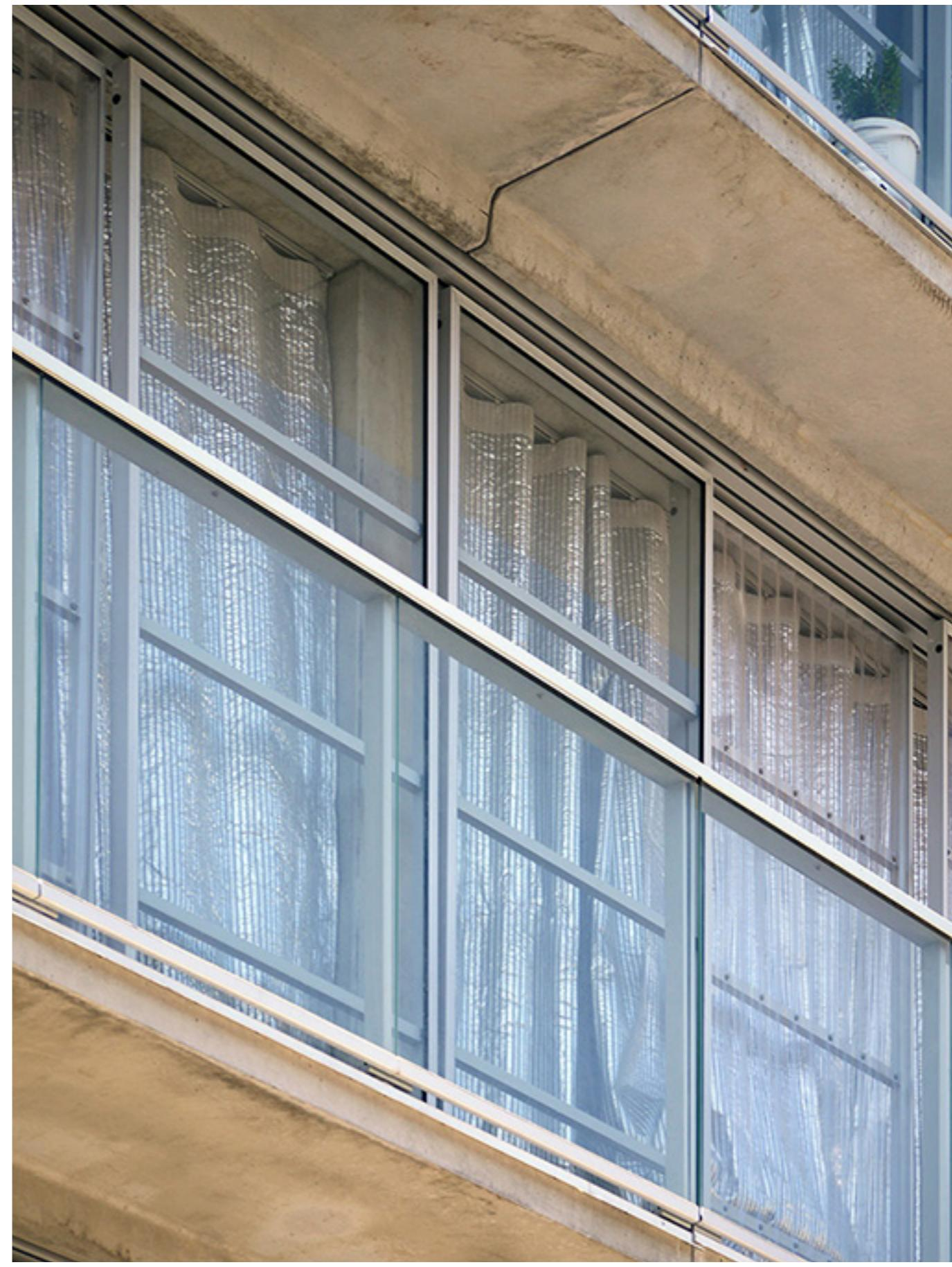
Particolare della serra (visibili le tende interne isolanti per il controllo della temperatura)
