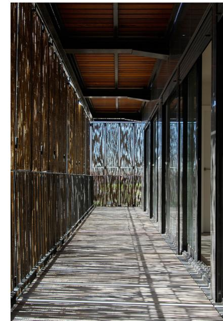
Dettaglio del sistema di schermatura - incannicciato di bambù su telaio in acciaio prieghevole
