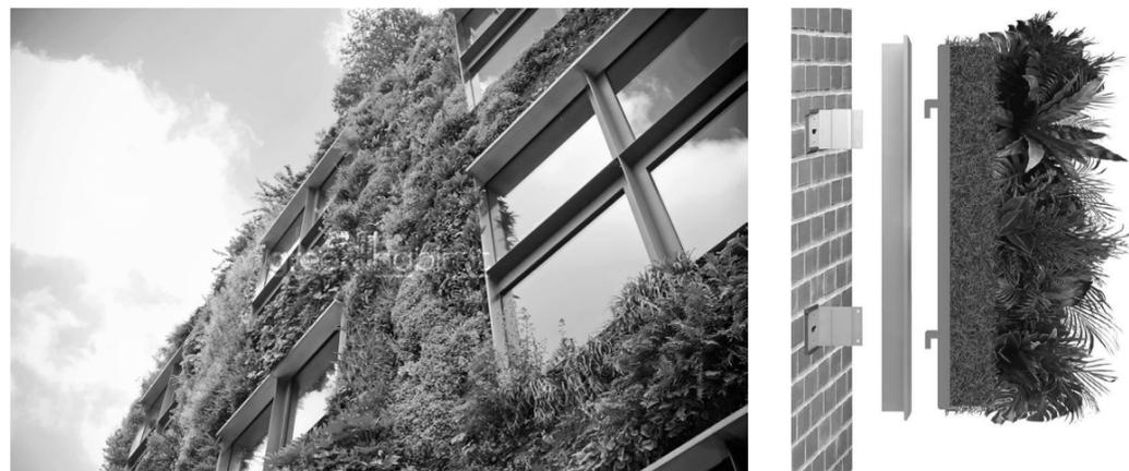
Fig. 9-10 Esempio di rivestimento di facciata con parete verticale verde, fissata tramite montanti a parete sui quali sono installati i moduli.
