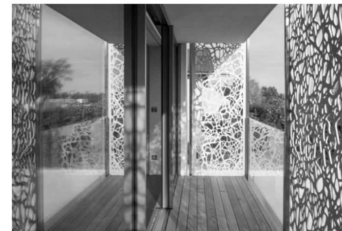
Fig. 13 Esempio di applicazione dei pannelli fonoassorbenti BRUAG Cellon. Il design e la percentuale di area di foratura dei pannelli sono totalmente personalizzabili.
