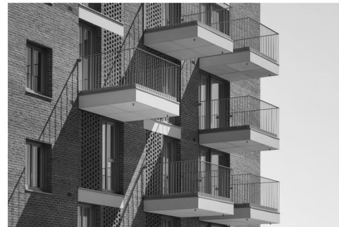
Fig. 11 Esempio di applicazione di pannelli fonoassorbenti QUIETSTONE Light nell'intradosso della soletta dei balconi.
