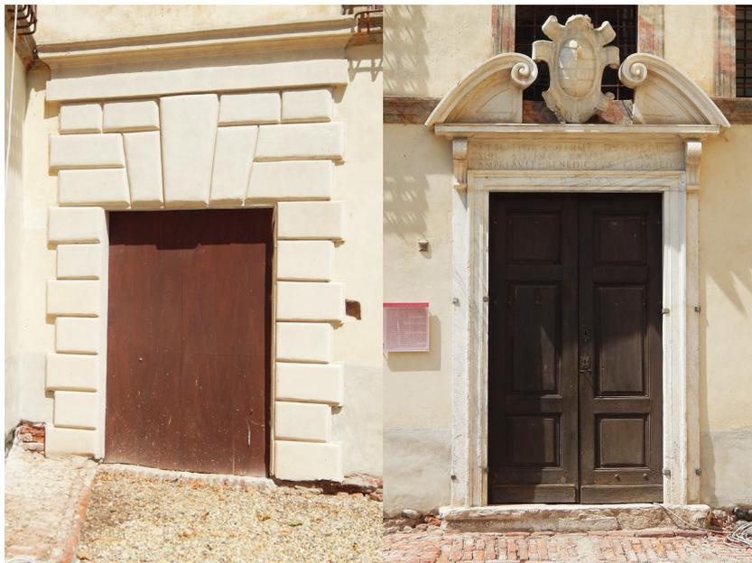
**Figura 4.61:** Il castello di ponente di Lagnasco. A sinistra: portale d'ingresso decorato con bugnato sul lato interno della manica di nord-est. A destra: portale d'ingresso marmoreo sul lato interno del corpo longitudinale del castello.
