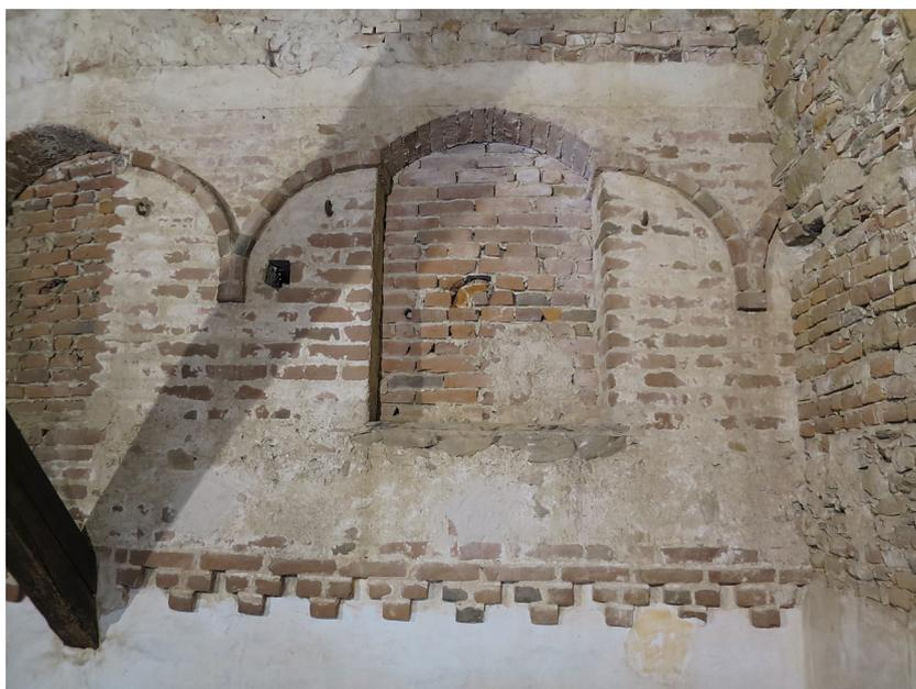
**Figura 4.4:** Il castello di Valerano: merlature del cammino di ronda, oggi tamponate e visibili nel sottotetto del palazzo di Michele Antonio.
