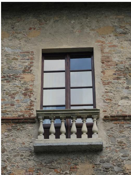
**Figura 4.9:** Il palazzo di Michele Antonio: prospetto ovest, dettaglio del balcone con balaustrini.
