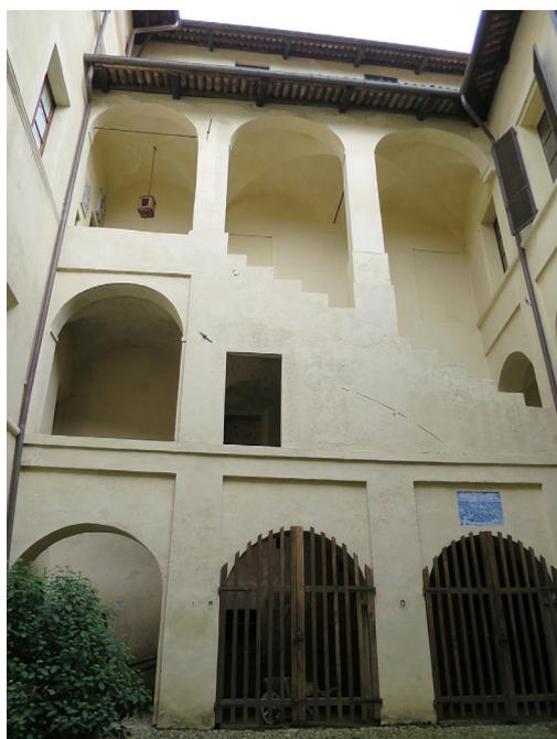
**Figura 4.8:** Il palazzo di Michele Antonio: loggiato del prospetto sud della corte, trasformato in scalone d'accesso nell'Ottocento.
