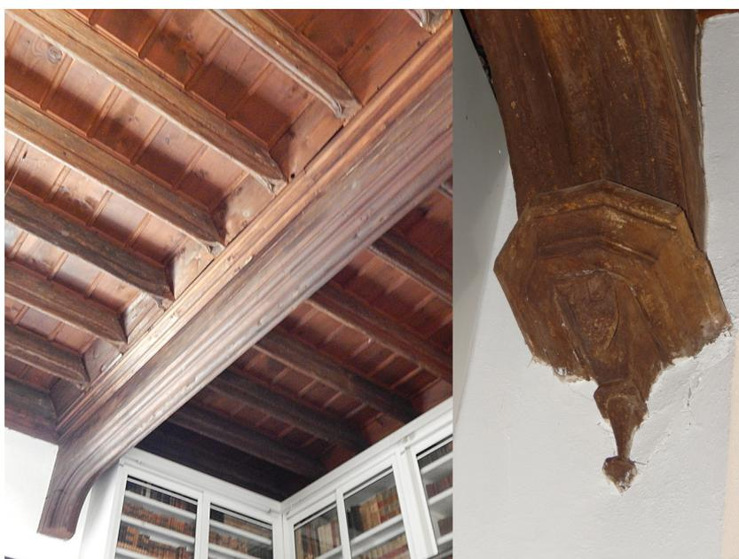
**Figura 4.96:** Il castello di Fossano: soffitto cassettonato del primo piano. A sinistra: veduta generale. A destra: particolare di un peduccio con lo stemma dei Savoia intagliato.
