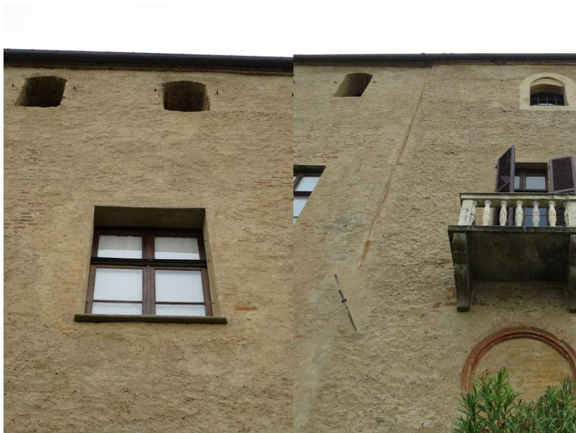
**Figura 4.3:** Il castello della Manta: tracce medievali sul prospetto sud del mastio trecentesco. A sinistra: segni delle finestre arcuate a sesto acuto. A destra: incontro delle differenti tessiture murarie di epoca tre e quattrocentesca.
