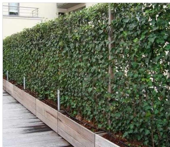
Figura 99. Esempio di applicazione di schermatura con struttura metallica ed edera, inserita in fioriere.
