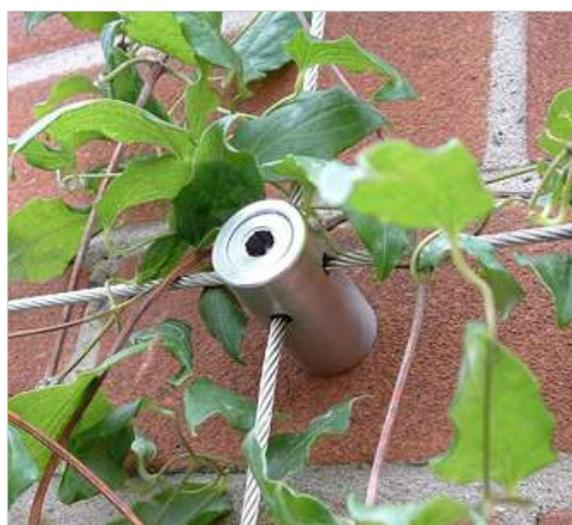
Figura 137. Esempio di applicazione della soluzione “*Green Wall*” *Cable Trellis System*
