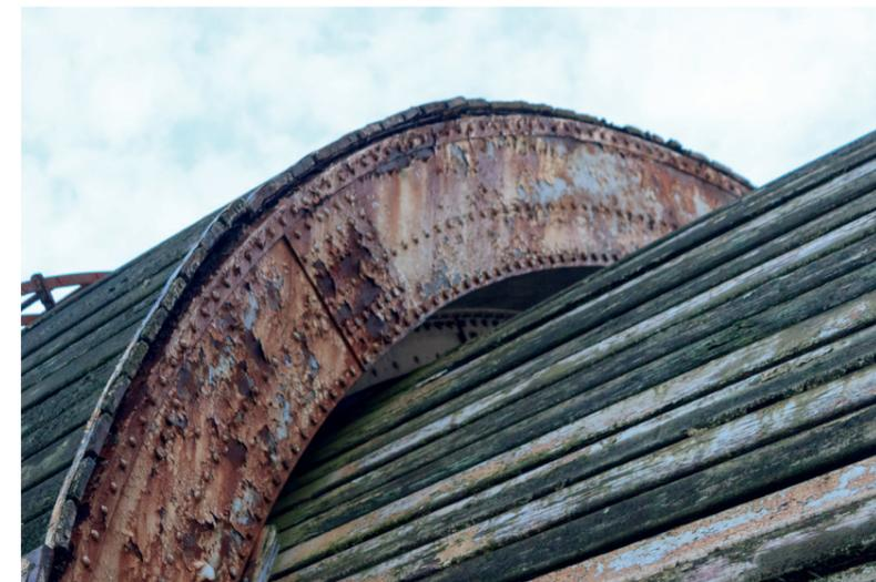
Fotografia dello stato di degrado degli archi portanti.
