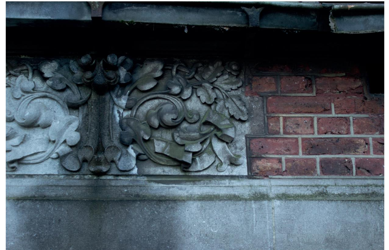
Fotografia dello stato di degrado dell'ornamento in *petit granit*.
