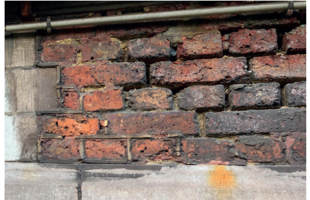
Fotografia dello stato di degrado della muratura facciavista.
