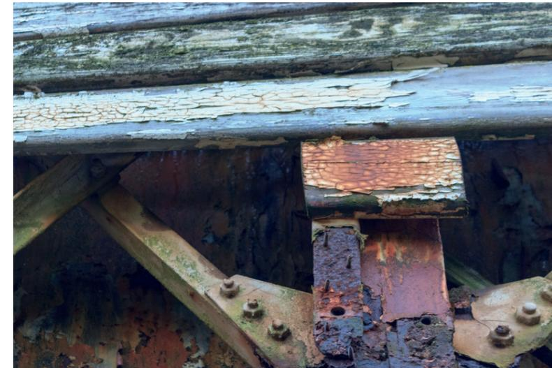
Fotografia dello stato di degrado delle controventature
