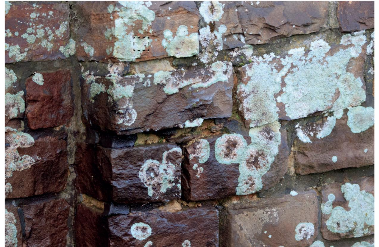
Fotografia dello stato di degrado del basamento in pietra arenaria.
