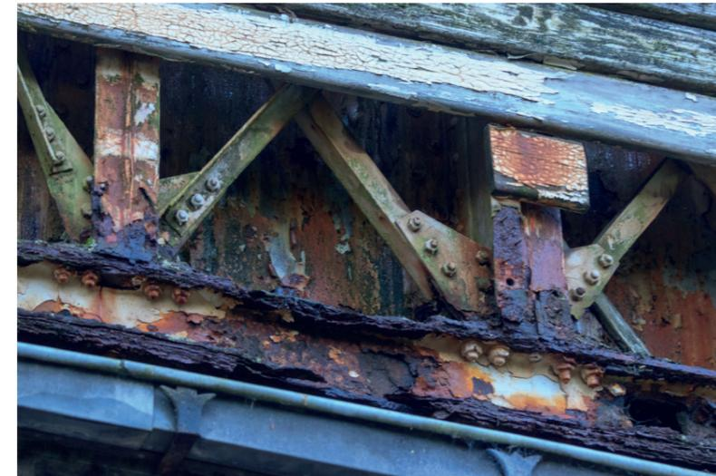
Fotografia dello stato di degrado della trave portante collocata alla base della struttura apribile
