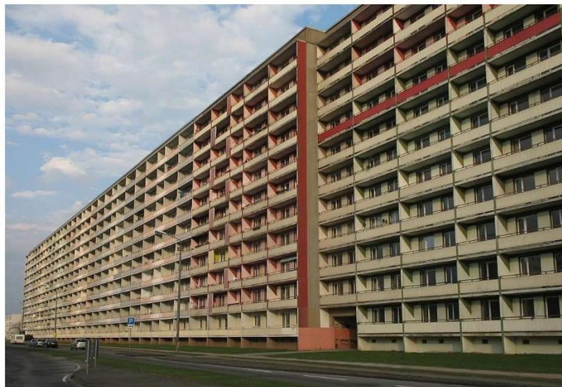
Figura 6 - Edificio realizzato con tecnica Plattenbau, Hoyerswerda, Germania (1955)<sup>13</sup>
