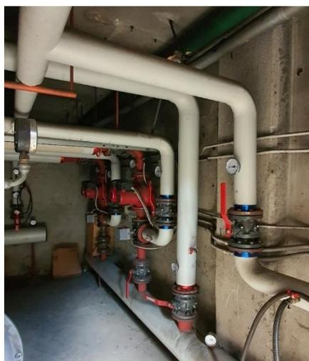
Figura 10 - Collettore verso impianto di riscaldamento
