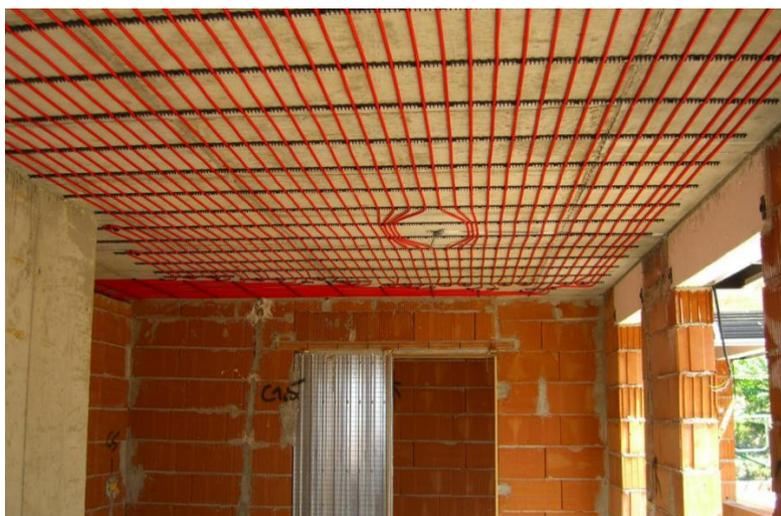
*Figura 33 - Installazione impianto radiante*
