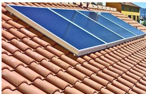
*Figura 51 - Esempio di pannello solare termico*
