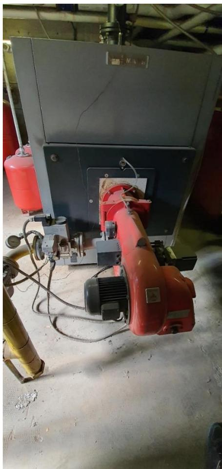
*Figura 8 - Caldaia a condensazione*
