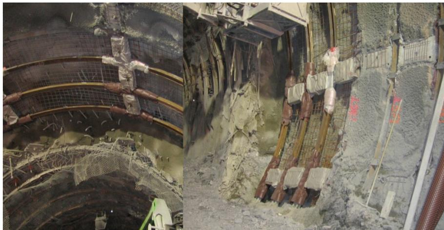
Figura 2.15 Installazione HDC nel rivestimento, St. Martin la Porte
