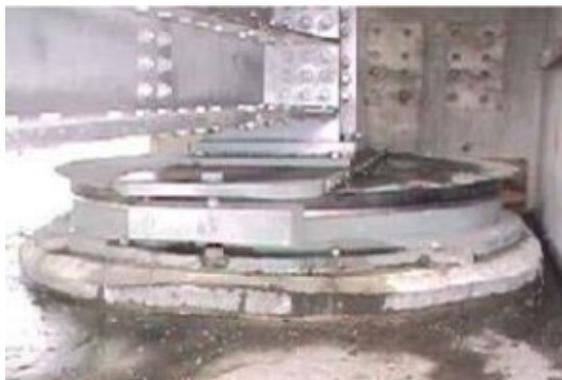
Figura 2.6: Esempio di isolatore a pendolo
