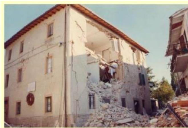
**Figura 5\_** Ribaltamento di una porzione di parete non ammortata in modo sufficiente
