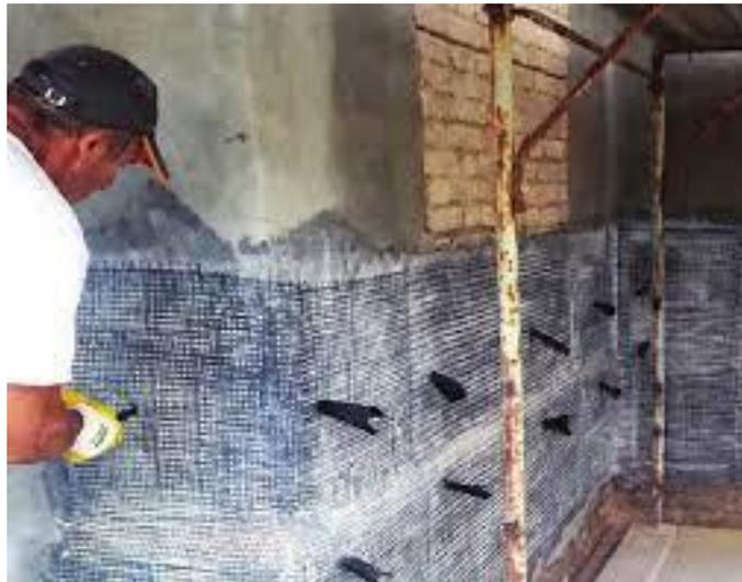
**Figura 16**\_Confinamento del pilastro in cemento armato tramite uso di sistemi FRP impregnati in situ
