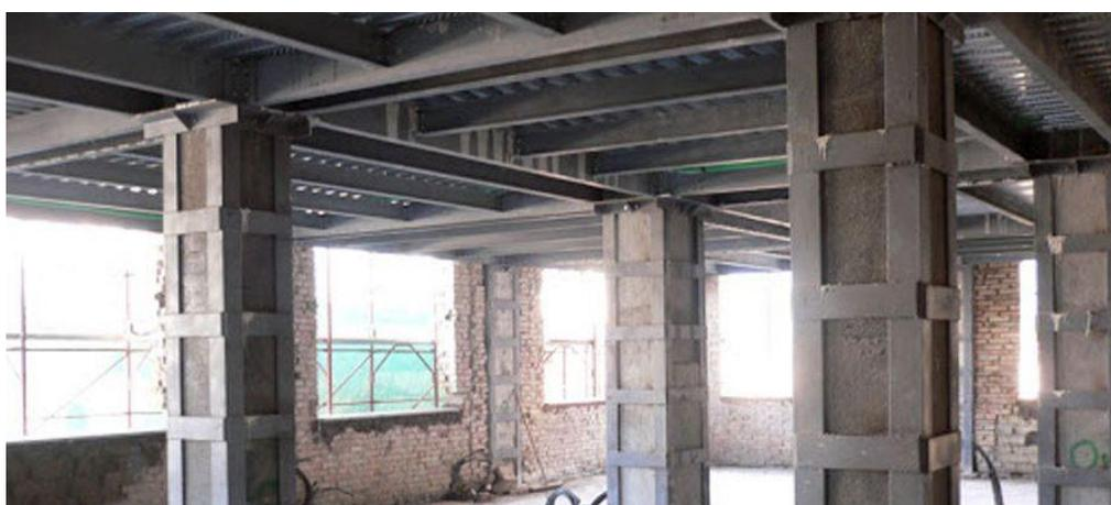
**Figura 8\_** Incamiciatura dei pilastri in c.a. tramite angolari e calastrelli a diretto contatto con faccia del pilastro
