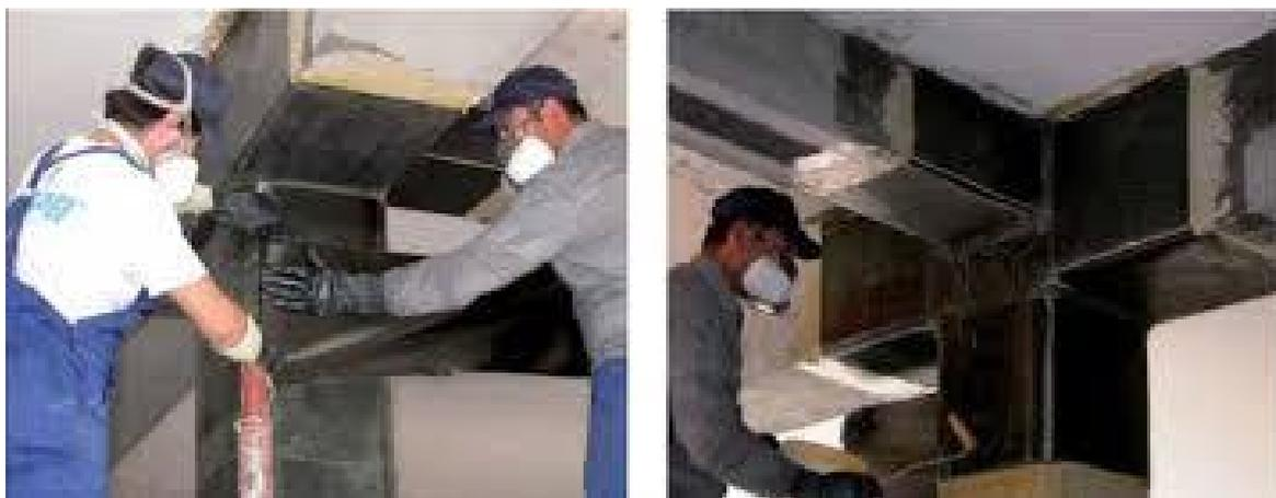
**Figura 17**\_ Confinamento del pilastro in cemento armato tramite uso di sistemi FRP preformati
