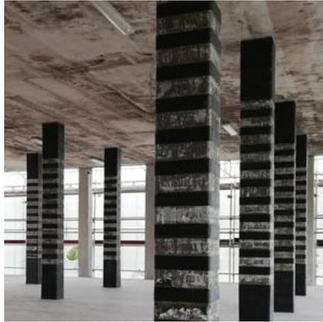
**Figura 15**\_Confinamento del pilastro in cemento armato tramite uso di sistemi FRP
