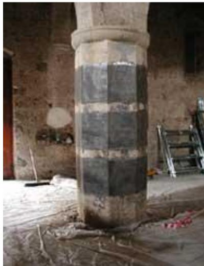
**Figura 18\_** Rinforzo di un pilastro in muratura tramite l'uso di sistemi FRP
