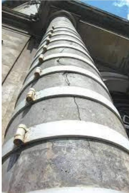
**Figura 10\_** Incamiciatura di un pilastro in muratura tramite delle fasce di acciaio
