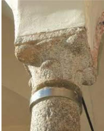
**Figura 11\_** Incamiciatura di un pilastro in muratura tramite uso di semi-anelli metallici
