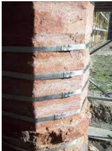
**Figura 12\_** Incamiciatura di un pilastro in muratura tramite delle bandelle esterne
