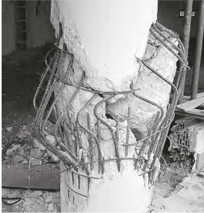
**Figura 2\_** Instabilizzazione per svergolamento dell'armature longitudinali
