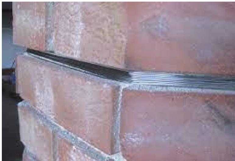
**Figura 14\_** Cerchiatura del pilastro in muratura tramite uso di cavi circolari in acciaio
