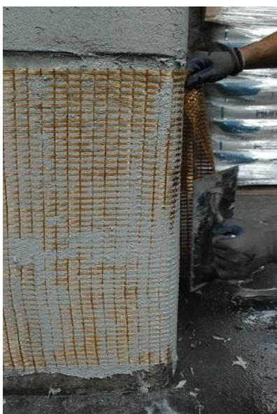
**Figura 20\_** Rinforzo di un pilastro in cemento armato tramite l'uso di fibre PBO
