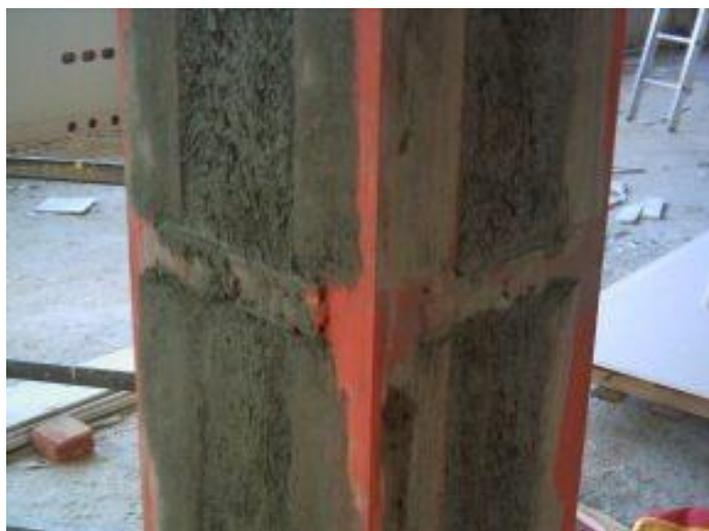
**Figura 9\_** Incamiciatura del pilastro tramite angolari e calastrelli con aggiunta di malta
