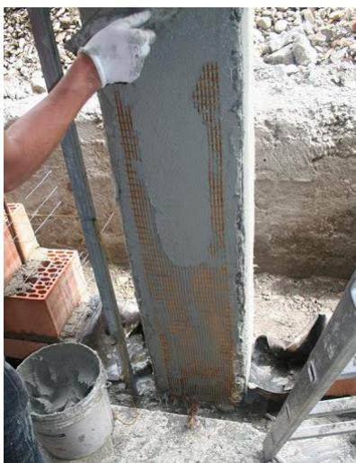
**Figura 19\_** Rinforzo di un pilastro in cemento armato tramite l'uso di sistemi FRCM
