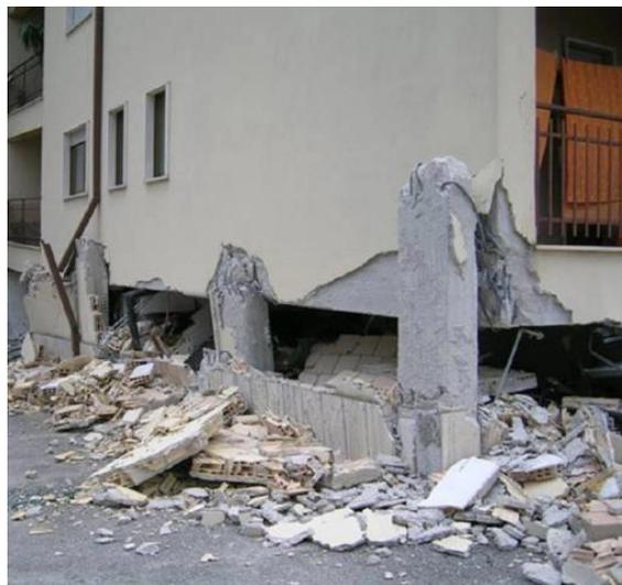
**Figura 3\_** Rottura per meccanismo per “piano soffice “
