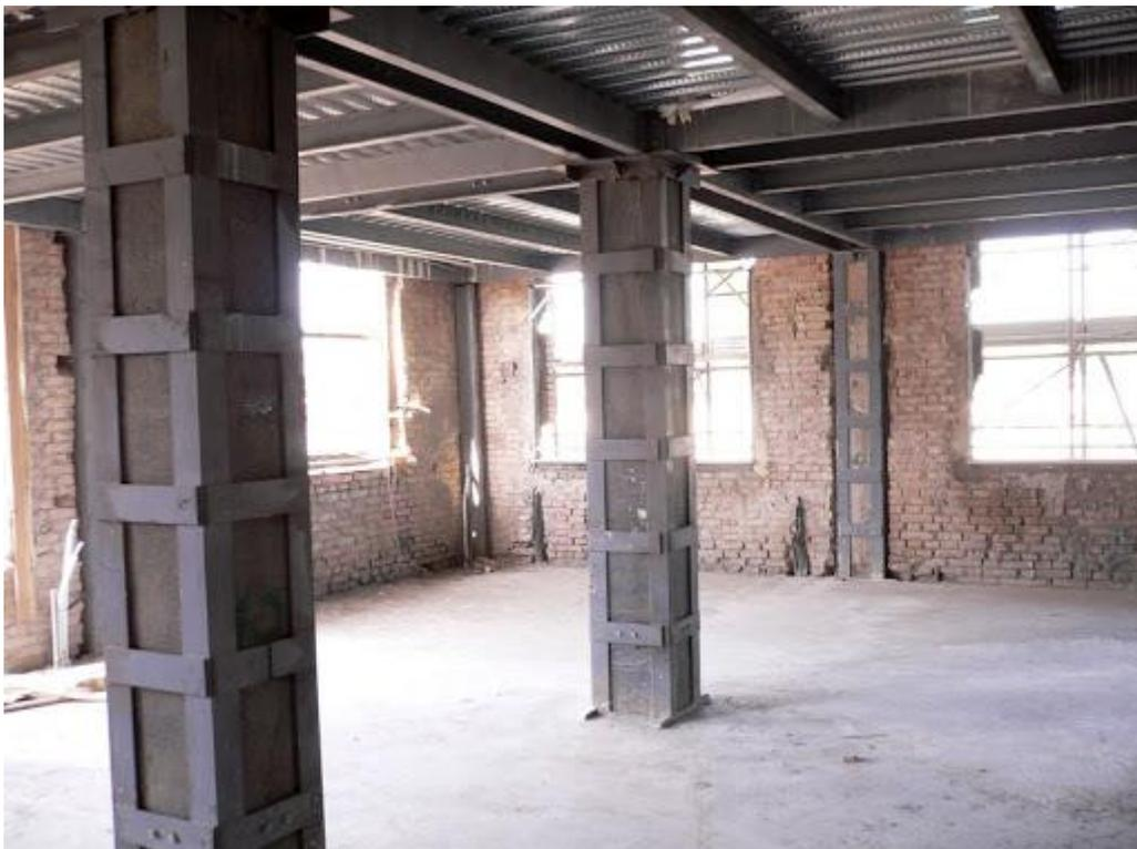
**Figura 7\_** Incamiciatura dei pilastri in c.a. tramite angolari e calastrelli
