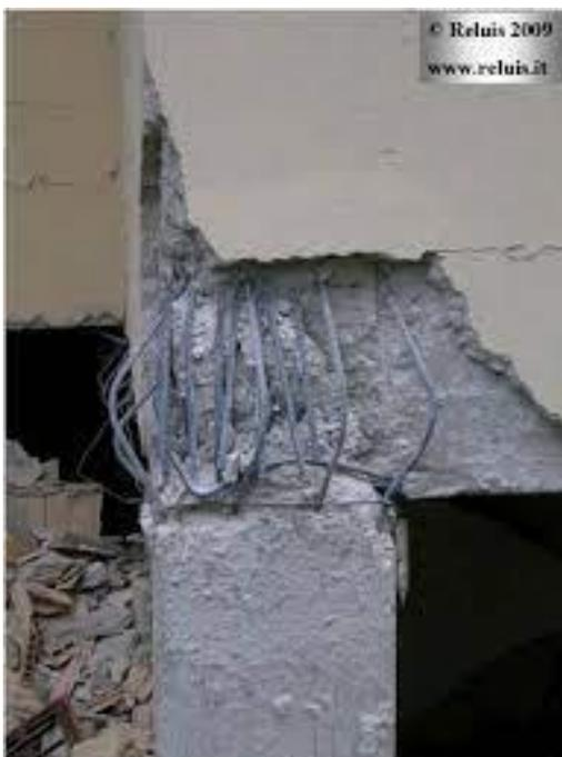
**Figura 1**\_ Collasso strutturale dei nodi
