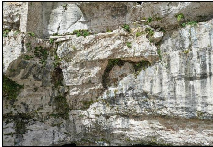
Figura 4.13 Area fratturata sotto l'arco
