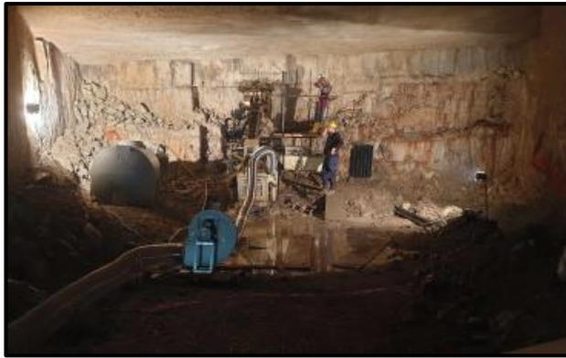
*Figura 3.2 Realizzazione foro di sondaggio S1*
