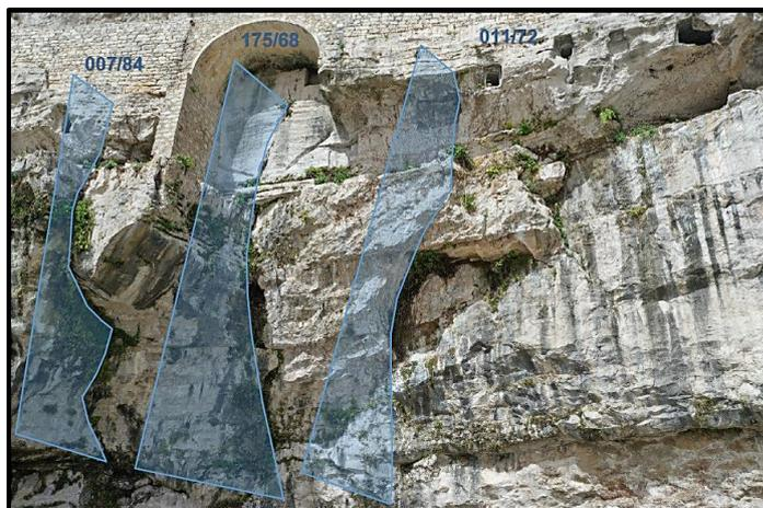
Figura 4.8 Discontinuità pervasive sub verticali nei pressi dell'arco in pietra
