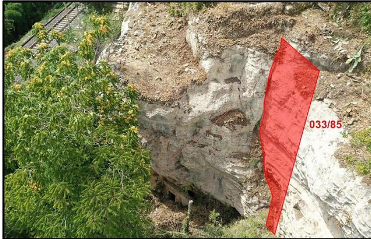
*Figura 4.30 Rappresentazione della discontinuità pervasiva sub parallela al fronte*
