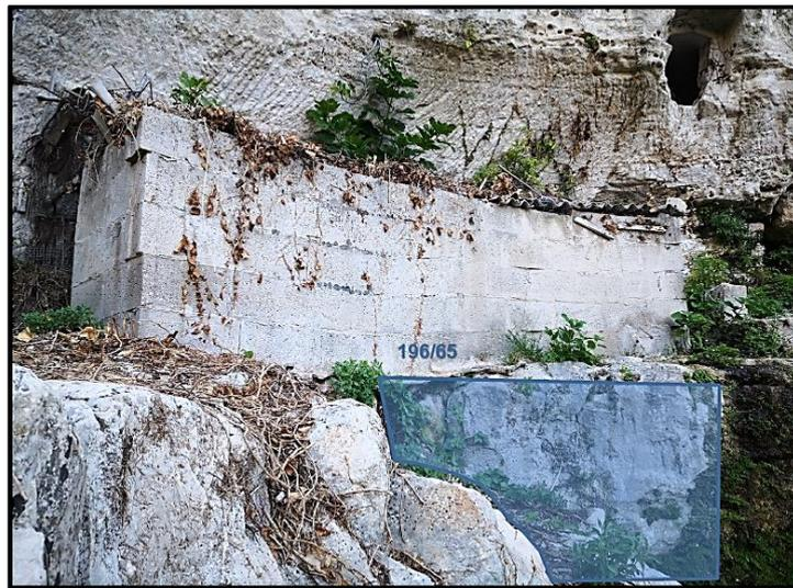
*Figura 4.9 Muro deformato della struttura in blocchi di cemento*
