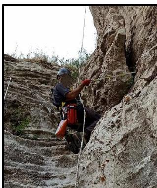
*Figura 4.23 Apertura della discontinuità alle spalle del masso discoidale*
