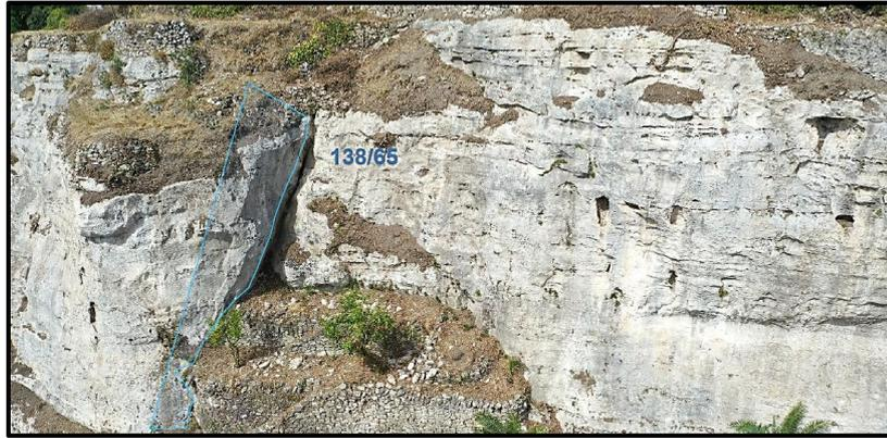
Figura 4.10 Importante discontinuità pervasiva sul fronte Nord-Est
