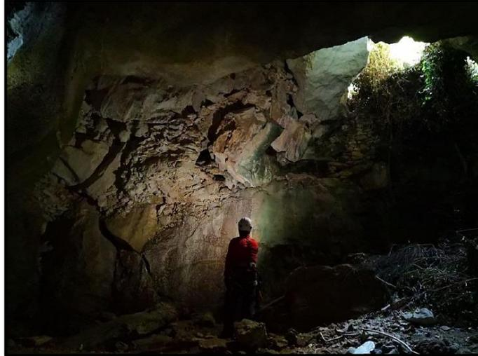
*Figura 4.31 Crollo all'interno della Latomia B lato Sud-Ovest*
