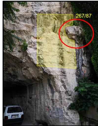
Figura 4.7 Masso isolato al limite Nord del fronte
