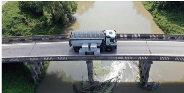
Figura 3.7: Prove di carico sui ponti.
