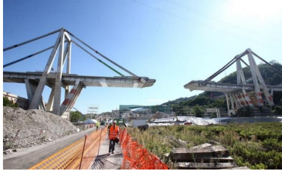
Figura 2.11: Crollo del ponte Morandi [12]
