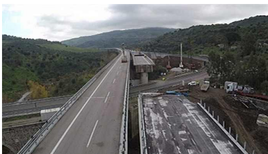
Figura 2.6: Crollo del viadotto Himera [12]
