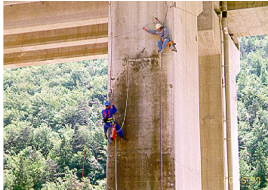
Figura 3.6: Ispezione straordinaria di una pila tramite discesa in corda doppia [20].
