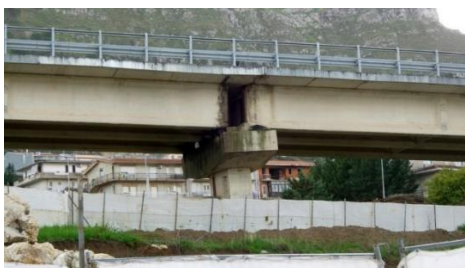
Figura 2.7: Crollo del ponte sulla statale Palermo – Sciacca [12]
