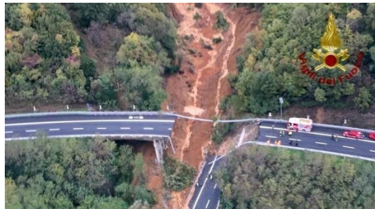
Figura 2.12: Crollo del cavalcavia su un tratto dell'autostrada A6 lungo la Torino-Savona [13]
