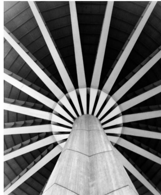
Fig. 2 Dettaglio pilastro Palazzo del Lavoro Torino
