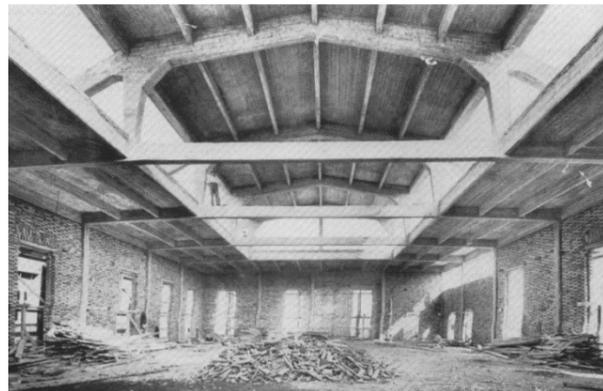
Fig. 3 Magazzino Tabacchi, piano coperture: la capriata in cemento armato.
