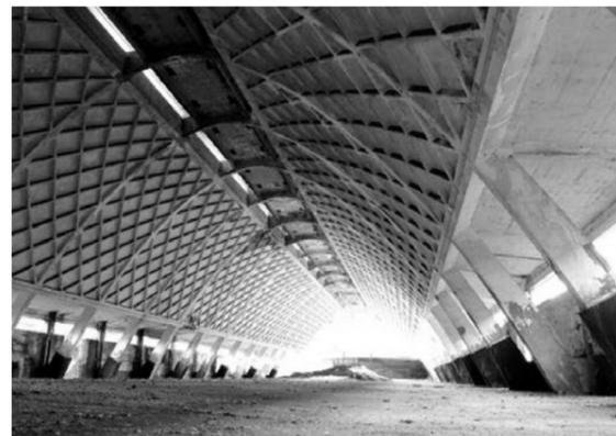
Fig. 5 Foto interna della volta nervata di uno dei capannoni di Tortona
