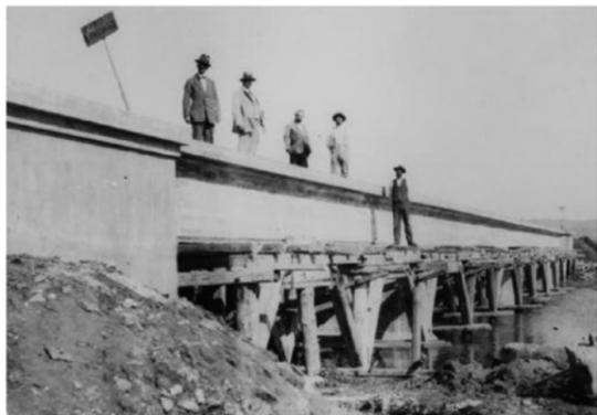
Fig. 6 Cantiere del ponte in cemento armato sull'Albegna presso Orbetello, in costruzione da parte della Società Anonima per Costruzioni Cementizie (1914). Nel primo uomo sulla sinistra in giacca e papillon è forse riconoscibile un giovane Pier Luigi Nervi.
