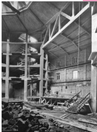
Fig. 7 Il cantiere di costruzione: in primo piano è visibile la struttura dei palchi e, sul fondo, quella della torre scenica. In alto, il solaio di copertura della sala (Fondazione Maxxi).
