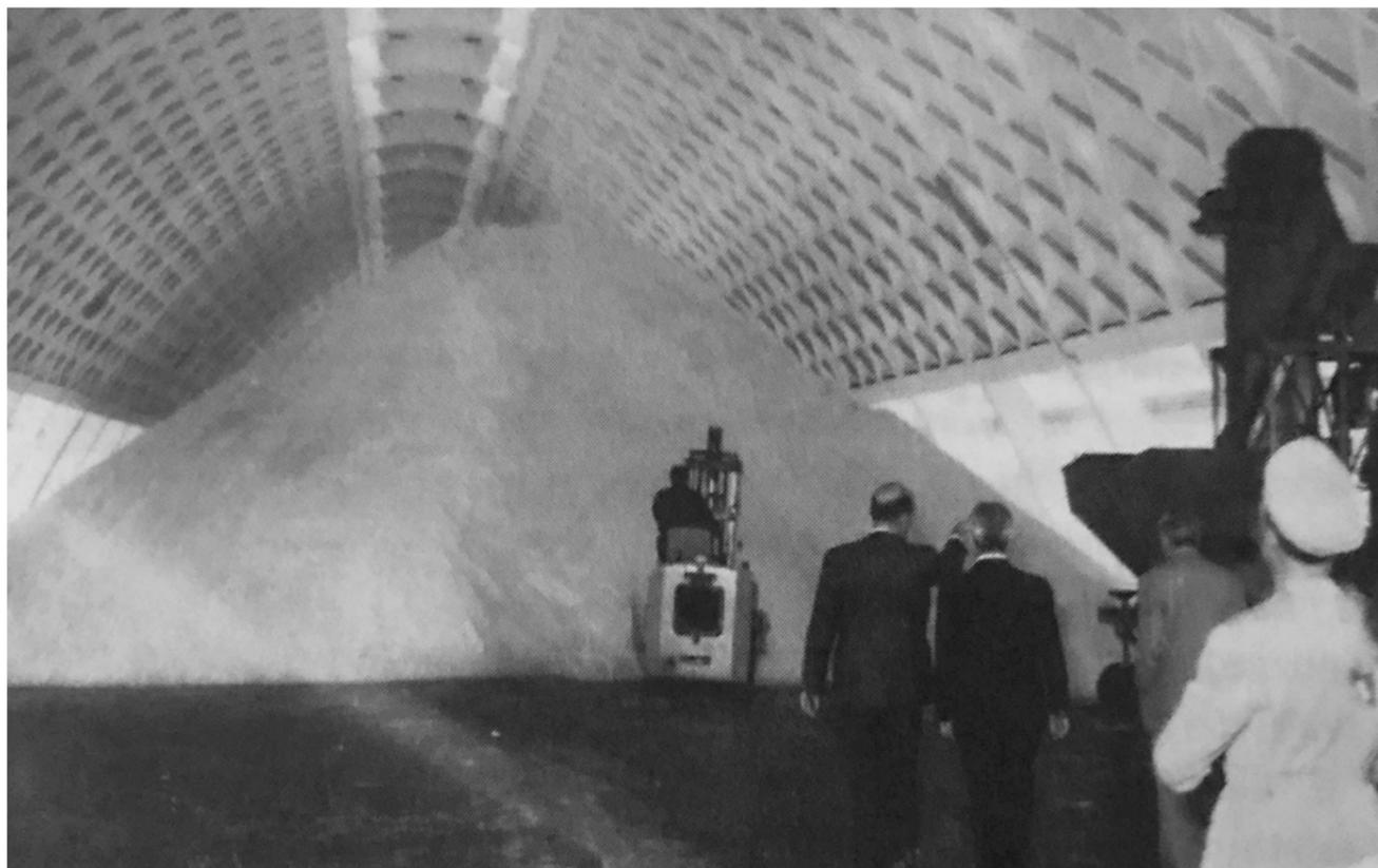
Fig. 1 Foto storica. Interazione tra "contenitore" (archi parabolici) e il prodotto contenuto al suo interno (montagna di sale).
