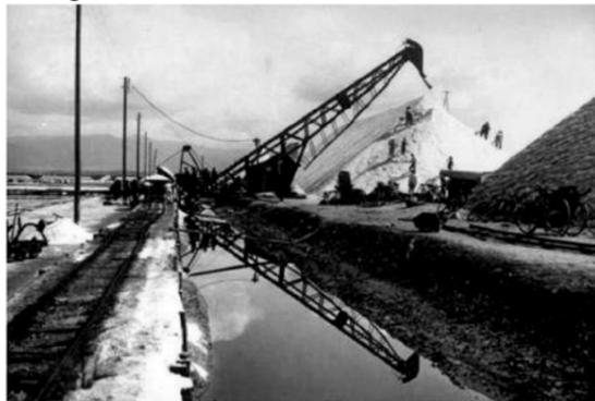
Fig. 5 Zona Pettiglio, formazione delle aie e impianto elevatore caricato con il sale trasportato da carrellini spinti a mano. (1935)
