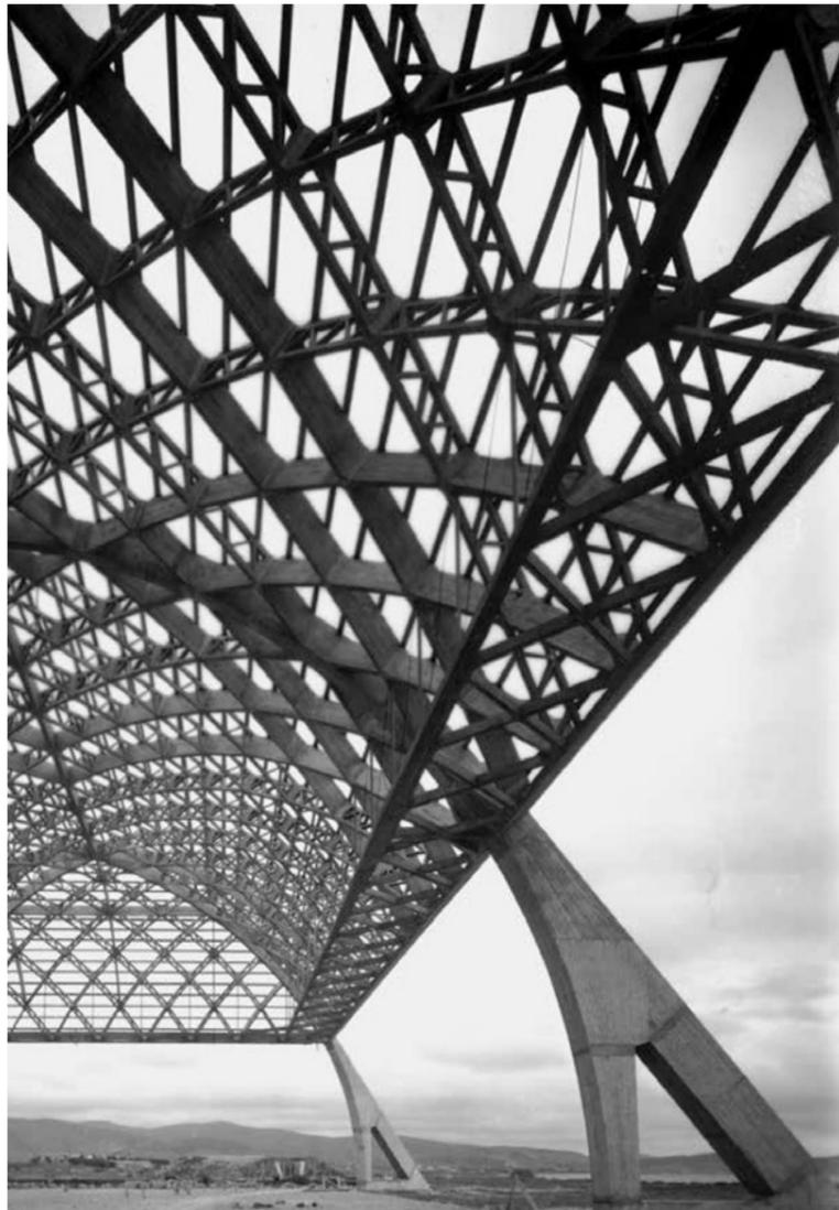
Fig. 1 Aviorimessa di Orbetello, in costruzione, dettaglio della struttura
