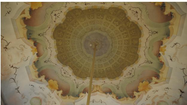
6. Sala antenati: Dettaglio del dispositivo di rilevamenti fumi, posizionato sopra la volta affrescata, sfruttando l'alimentazione fornita dagli impianti di illuminazione. Nell'inserimento dei nuovi sistemi di illuminazione, si vuole mantenere inalterato il contesto architettonico, sfruttandone la conformazione per nascondere le sorgenti luminose agli occhi degli osservatori.
