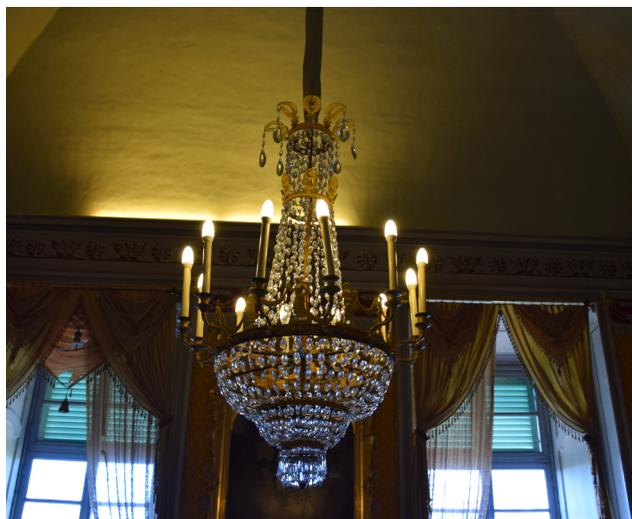
3. Sala Gialla: dettaglio dell'apparecchio di illuminazione storico, per il quale sono state impiegate sorgenti luminose LED con bulbo opalino, e delle sorgenti fluorescenti lineari installate sui cornicioni, all'imposta della volta, di cui una risulta non funzionante. Anche qui si prevede l'integrazione di illuminazione generale diretta ed indiretta con apparecchi lineari a LED, da sostituire agli apparecchi attualmente presenti.
