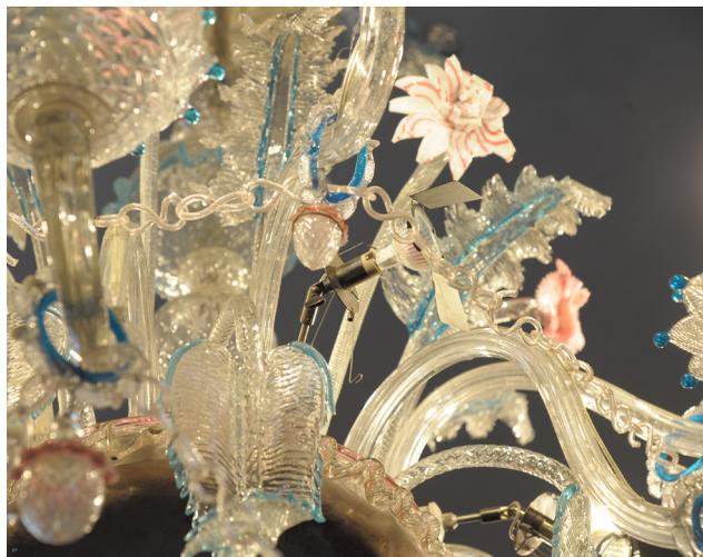
1. Sala valletti: Vista del lampadario da sottoporre a restauro conservativo per ripristinarne l'aspetto originario, e dei miniproiettori LED installati sull'apparecchio di illuminazione storico, non funzionanti.
