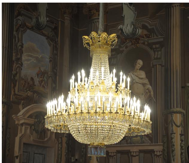
2. Salone da Ballo: dettaglio dell'apparecchio di illuminazione storico, per il quale sono state impiegate sorgenti luminose LED con bulbo opalino. Si prevede la sostituzione delle sorgenti attualmente installate con sorgenti LED, con bulbo ad oliva trasparente, per migliorare la resa luminosa generale.
