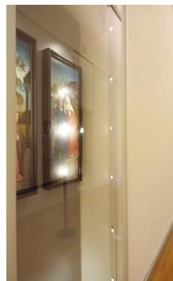
Per i dipinti protetti da uno strato di plexiglass, è stato realizzato un sistema dedicato, costituito da due file da 6 faretti ciascuna, disposti verticalmente. I faretti sono ad incasso, orientabili, con movimento basculante ad ampio raggio e rotazione sul proprio asse a 355°, opportunamente collocati su una superficie verticale inclinata, al fine di evitare riflessioni eccessive.
