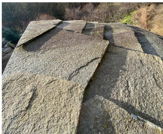
Figura 3.10 - tetto con copertura in lose - 2021
