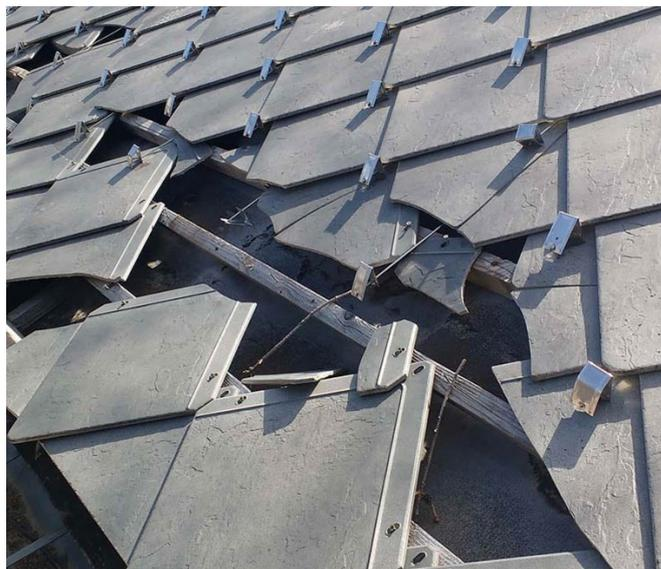
Figura 6.3 - Sostituzione delle lose danneggiate del tetto del municipio di Sauze d' Oulx - Ahora Architettura - 2016
