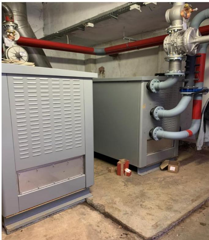
*Figura 24 Nuove Caldaie UNICAL Modulex 770*
