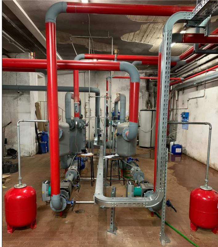
*Figura 25 Scambiatori di calore a piastre, collettore di centrale e defangatori*
