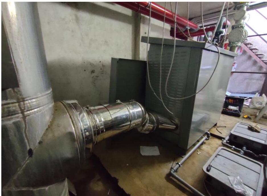
*Figura 23 Raccordo tra la nuova caldaia e la condotta per evacuazione fumi*
