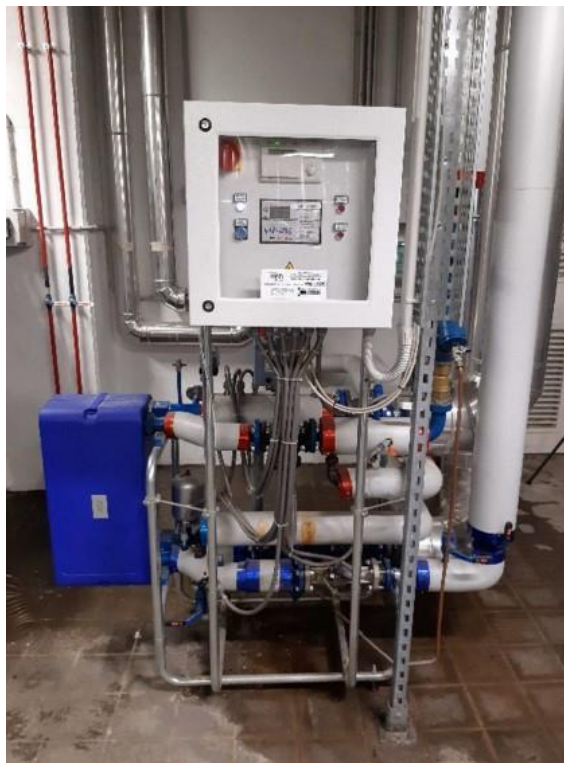
Figura 4.7 Scambiatore teleriscaldamento
