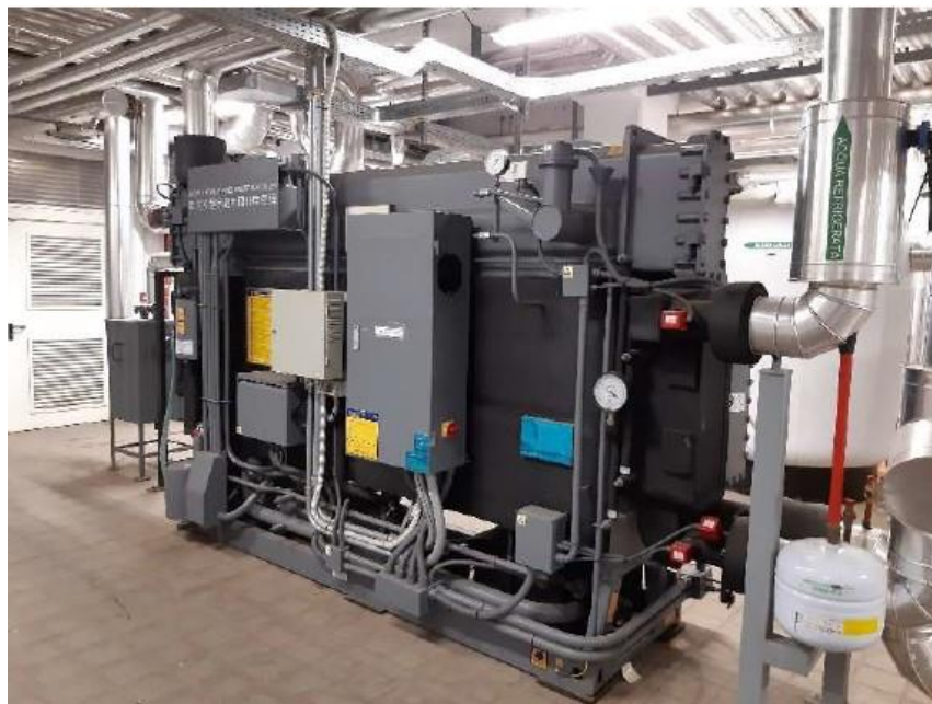
Figura 4.2 Macchina ad assorbimento
