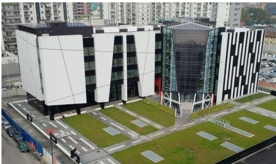
Figura 4.1 Edificio Energy Center
