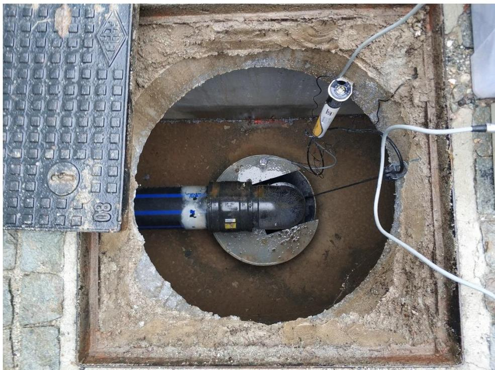
Figura 44: Pozzo di restituzione P8; si può notare la sonda OTT appesa sulla destra e la tubazione dell'impianto di restituzione a gravità
