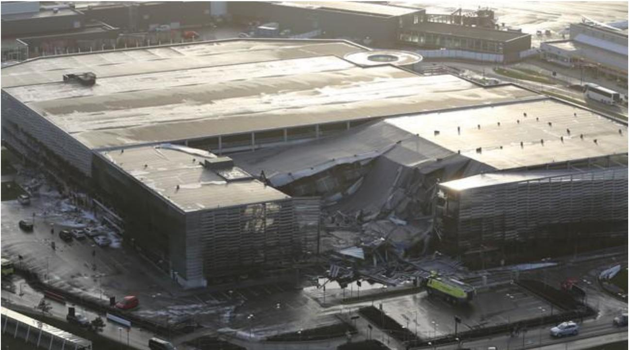
Figura 5. Foto dell'incendio del parcheggio multipiano di Stavanger
