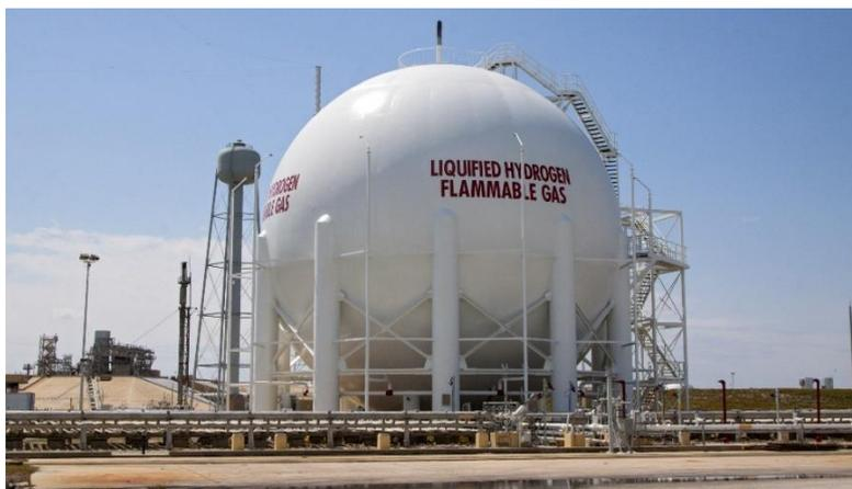
**Figura 1.5:** Serbatoio di idrogeno liquido che ha supportato i lanci dello Space Shuttle per 30 anni, presso il Kennedy Space Center della NASA ([Applicazioni spaziali di idrogeno e celle a combustibile | NASA](#), Crediti: NASA/Kim Shiflett).
