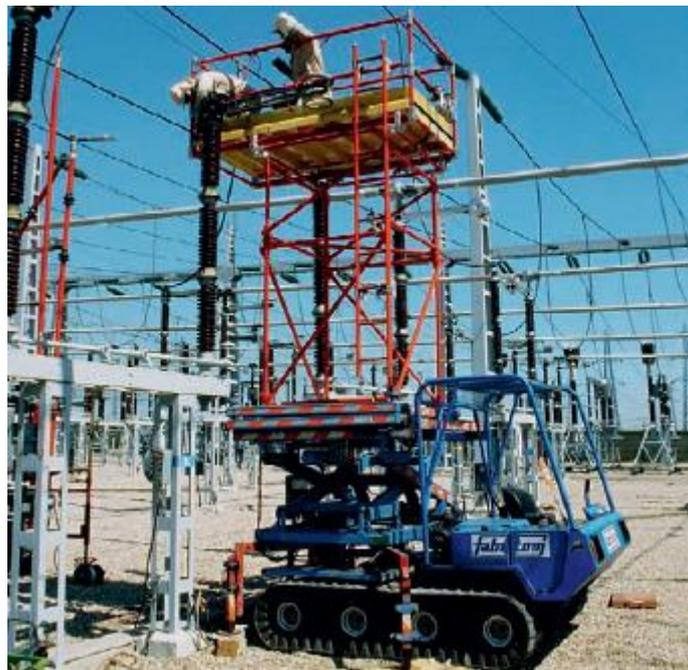
*Fig. 5.2.4: Torre isolante di posizionamento (TIP)*
