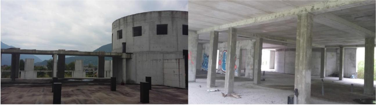
Figura 1.13 – Scheletro strutturale del palazzetto dello sport di Crevoladossola [37]
