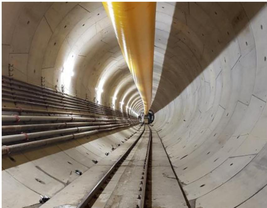
Figura 3.4 Rivestimento definitivo in anelli di calcestruzzo armato prefabbricati (Damiani et al., 2018)
