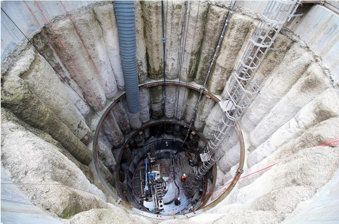
Figura 3.17 Pozzo per l'esecuzione delle iniezioni di compensazione ([www.trevispa.com](http://www.trevispa.com))
