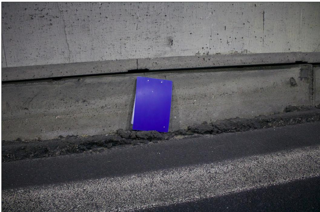
Figura 3.63: Comparazione tra un portablocco A4 e la magnitudo della deformazione delle banchine laterali ad una chilometrica autostradale non specificata (19/04/21 – sopralluogo *in situ*).
