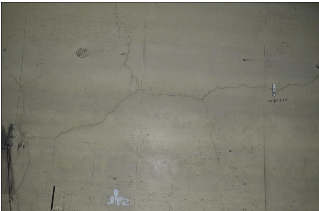
Figura 3.61: Stato fessurativo della volta in corrispondenza della chilometrica autostradale 207+877 (19/04/21 – sopralluogo *in situ*).
