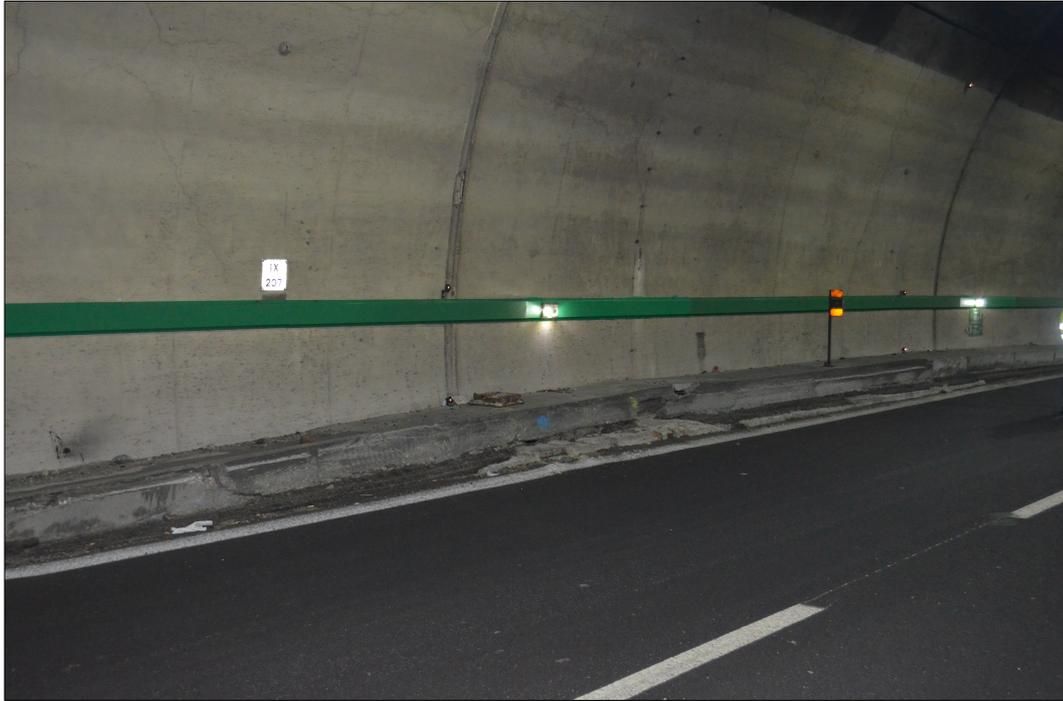
Figura 3.62: Sollevamento delle banchine laterali in corrispondenza della chilometrica autostradale 207+873 (19/04/21 – sopralluogo *in situ*).
