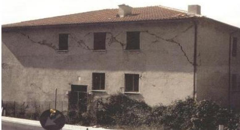
Figura 5.2 Esempio di rottura nel piano di una parete, crisi per taglio del maschio [18]
