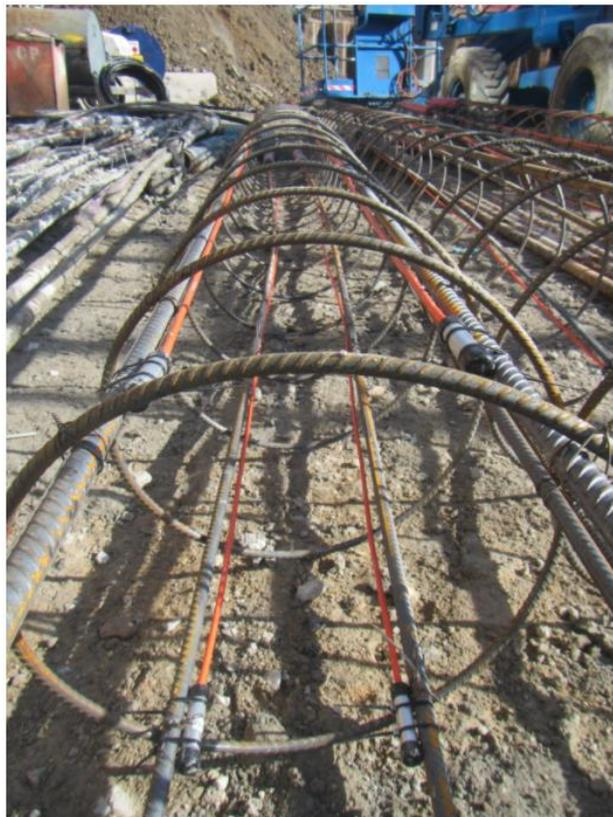
*Figura 15. Tubazioni di scambio termico accoppiate all'armatura del palo di fondazione
