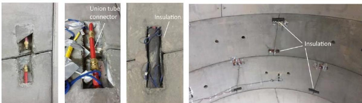
Figura 26. Connessioni dei tubi dei circuiti tra conchi adiacenti, assicurati con nastro isolante (Barla et al., 2019)
