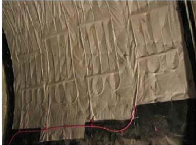
Figura 22. Geotessile con tubi di scambio nel tunnel energetico Lainzer, a Vienna (Brandl, 2006)
