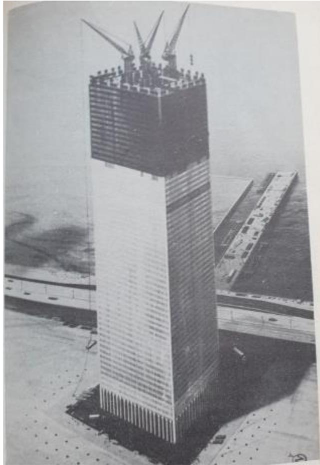
Fig. 7 - Trade World Center. Schema di montaggio con gru a braccio
