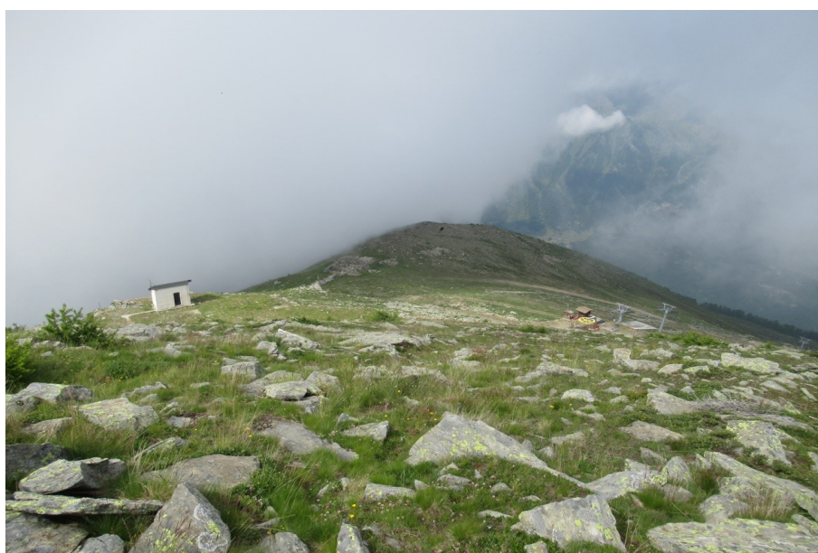
Figura 4.12: Vista della stazione di monte dell'impianto Pian dell'Alpet-Bric Rond (2540m s.l.m) e del piccolo fabbricato rettangolare con copertura a falda unica lungo la mulattiera militare
